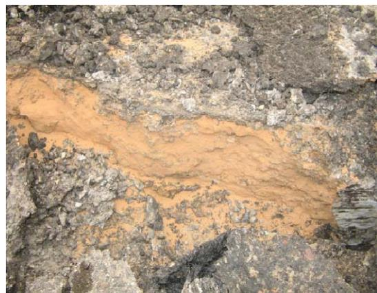
**FIGURE I.13 :** Fissure envahie par le sable éolien
