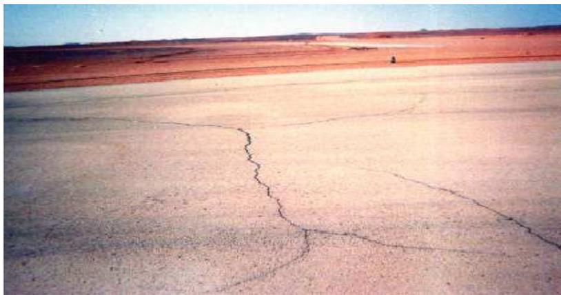
**FIGURE I.5 Aéroport ILLIZI : PISTE PRINCIPALE :** Apparition des fissures à maille large sur la raquette (seuil 09)
