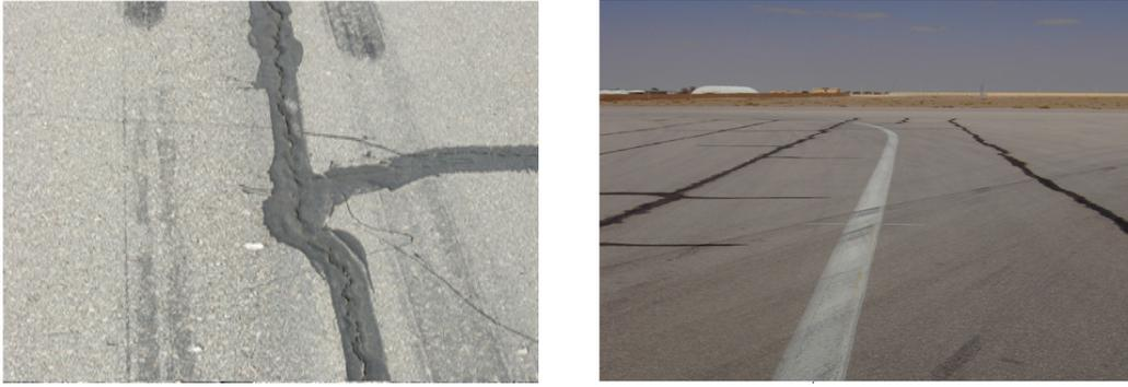
**FIGURE I.19 :** Les photos ces dessus de la Bretelle 1 ; Réapparitions des fissurations après le colmatage
