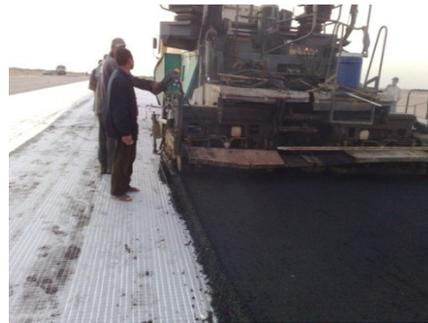
Mise en œuvre de la couche de roulement en BB
