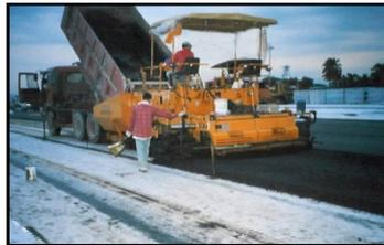
Contrôle des rejets des 50 cours De liant SMA mm.
