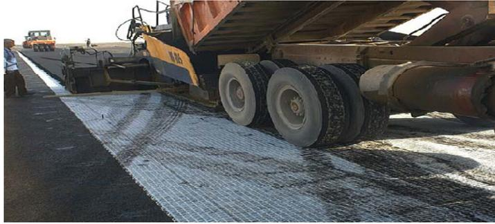
Mise en œuvre de la couche de roulement en BB 0/14
