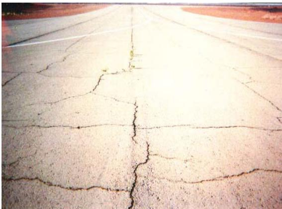
**FIGURE I.10:** Fissures de retrait thermique
