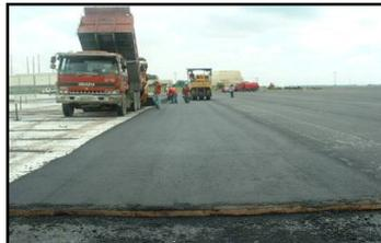
Présentation de béton bitumineux étant sortie de chargeuse sur chenilles.
