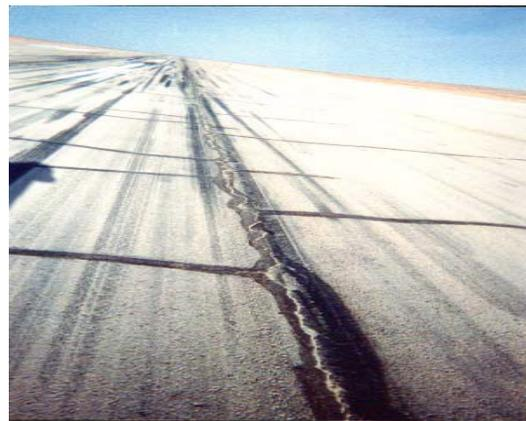
**FIGURE I.11 :** Fissure longitudinale de joint
