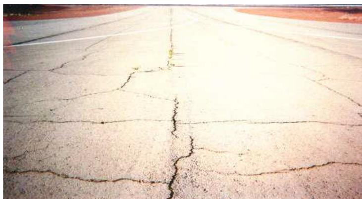
**FIGURE I.15:** Accumulation de fissures longitudinales et transversales faïençage à maille large sur la bretelle N°03 ; -présence des fissures de fatigue. Essartement important des fissures, manque d'entretien (fissures non colmatées)
