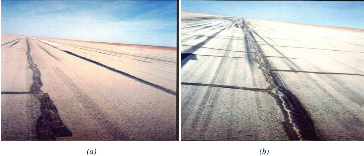
**Figure III.2 : Aériodrome ILLIZI :** Colmatage de fissures de joints au milieu de la piste non réussi (les bandes centrales)      dépôt de gomme important, formation de mailles larges par combinaison fissures longitudinale et transversale
