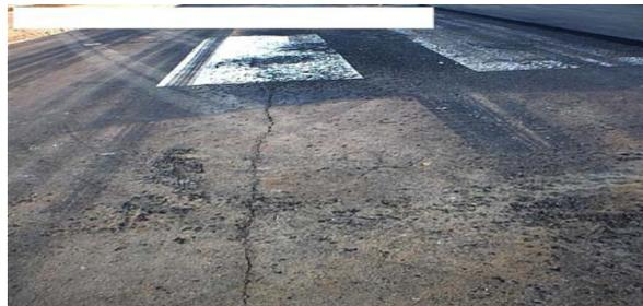
Figure III.10 : Fissure longitudinale de remontée après la mise en œuvre de la GB 0/20
