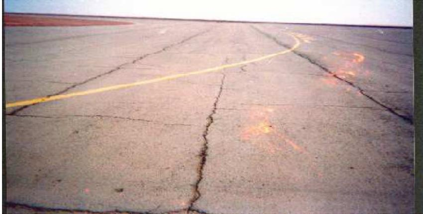
**FIGURE I.6 Aéroport ILLIZI : BRETELLE N°02 :** Présence de fissures de joints et celles transversales formant faïençage à maille large.
