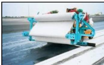
Pavage installation du tissu en utilisant
