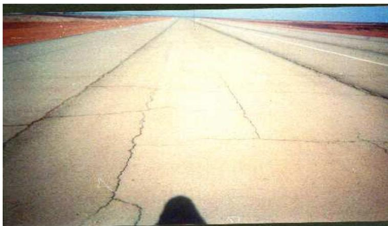
**FIGURE I.7 Aéroport ILLIZI : TAXIWAY** Fissures longitudinale et transversales formant un faïençage à maille large.
