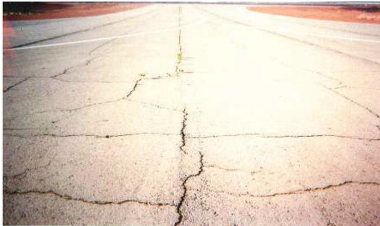
**FIGURE I.8 Aéroport DJANET :** Accumulation de fissures longitudinales et transversales faïençage à maille large sur la bretelle N°03.
