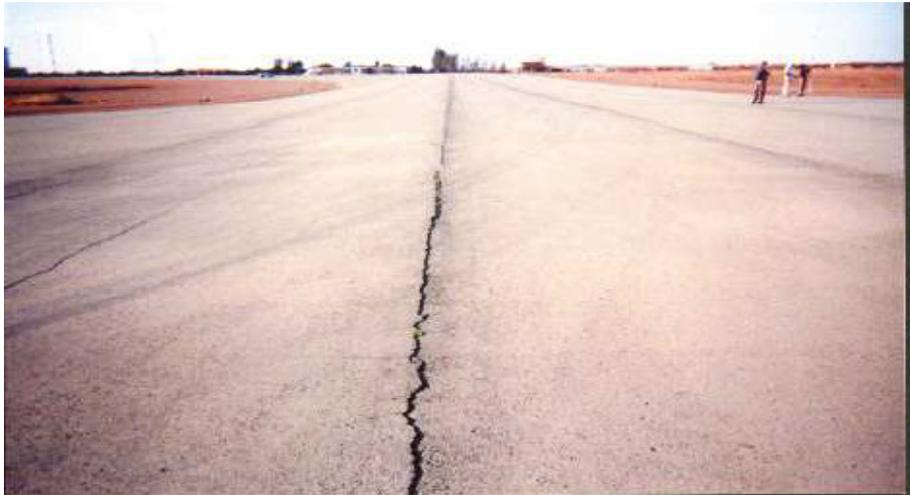
**FIGURE I.4 : Aéroport ILLIZI:** Fissures longitudinales non colmatées sur la bretelle N°01
