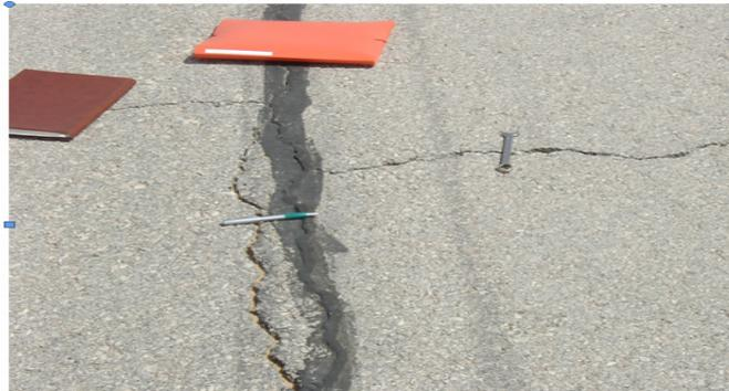
**FIGURE I.23:** Réapparition des fissures + nouvelles fissures
