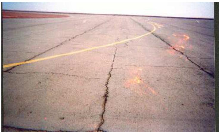
**FIGURE I.14 :** Présence de fissures de joints et celles transversales formant faïençage à maille large, Écartement des fissures important, manque d'entretien (fissures non colmatées)
