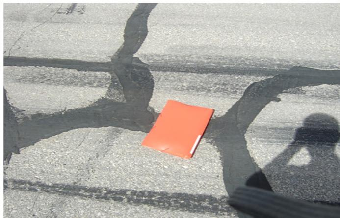
**FIGURE I.9 Aéroport Ouargla la piste principale : FISSURES PARABOLIQUES**
