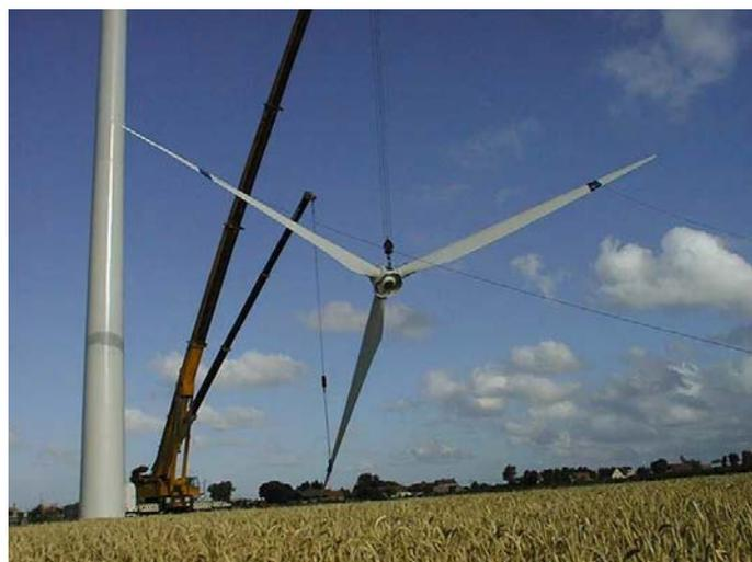
Figure I.10 : Rotor d'une éolienne en montage.
