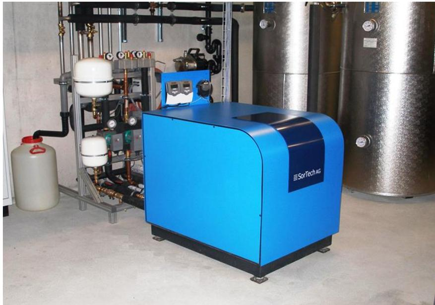
**Fig. 2.2.** Images de la machine à adsorption ACS 08, de marque SorTech AG [31].
