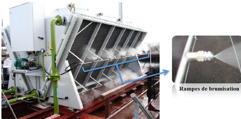
**Fig. 2.19.** Principe de fonctionnement du système de refroidissement par aéroréfrigérant sec, plus système de pulvérisation adiabatique [44]
