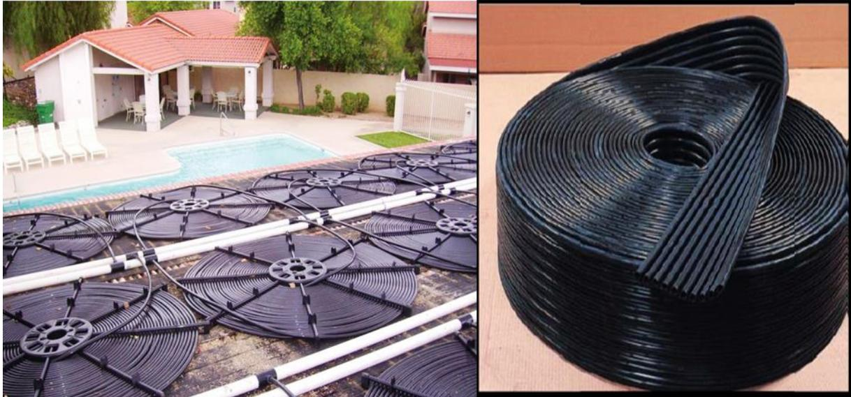
Fig. 2.6. Capteur solaire Les capteurs sans vitrage [59].
