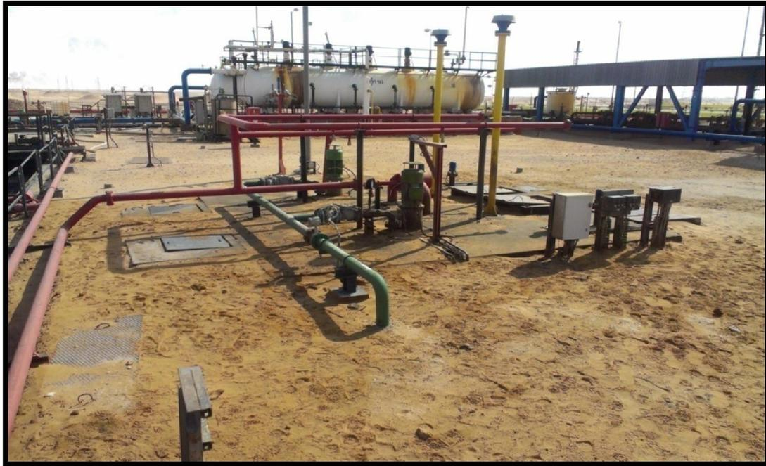
Figure. I.5. Puisard d'huile et pompes de transfert d'huile.
