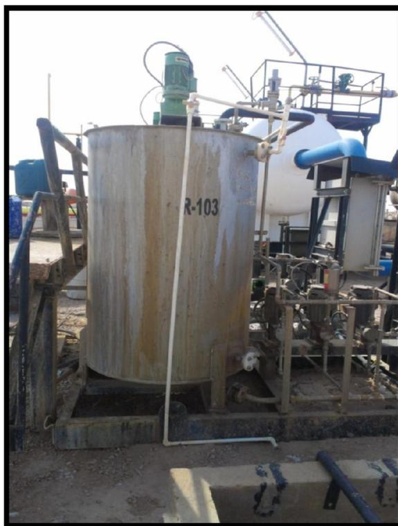
**Figure. I.8.** les skids d'injection de produits chimique.
