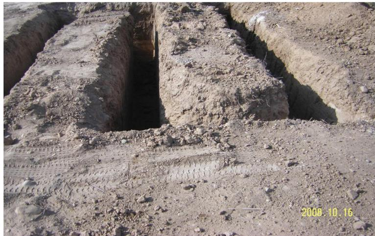
**Figure (III-1) :** tranchées pour installation de l'échangeur enterré air/sol
