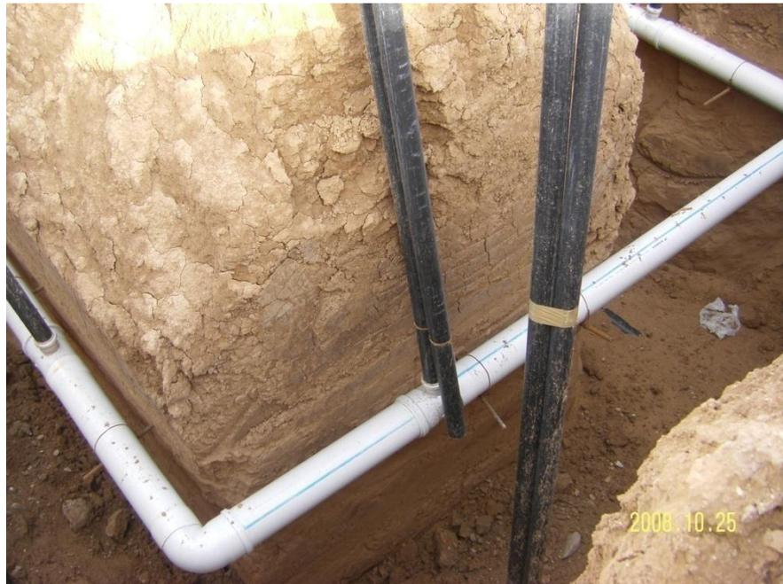
Figure (II-7) : échangeur ail/sol tubulaire enterré.
