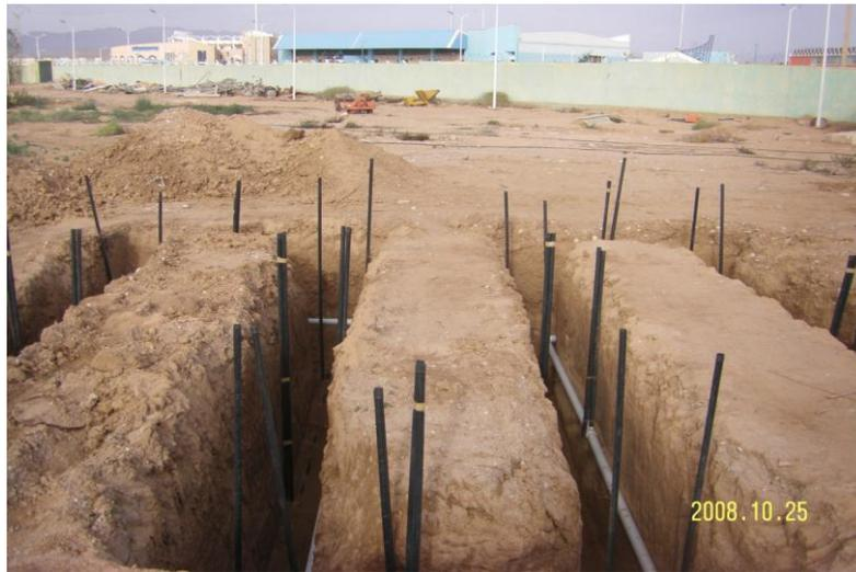
**Figure (III-2) :** pose de l'échangeur air/sol enterré avec conduites pour installation des thermocouples de mesure de la température.
