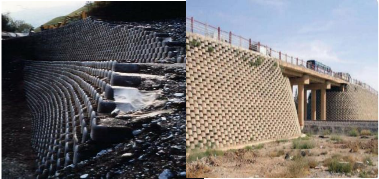
Figure 1.6: Mur en sol renforcé.
