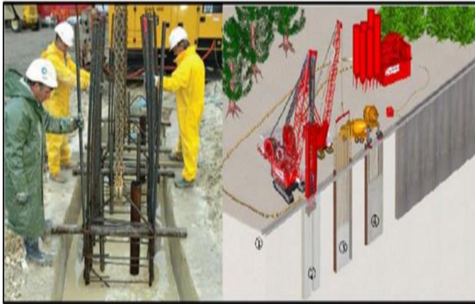
Figure 1.8: Murs en parois moulées.
