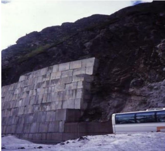
Figure 1.2 : Mur de poids.
