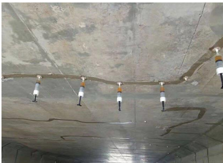
Figure II. 3 :Injection des fissures par résine.
