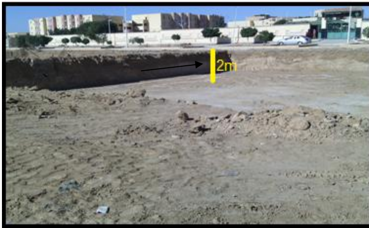
Figure.1.29. Mesure de la profondeur de fouille (bon sol).
