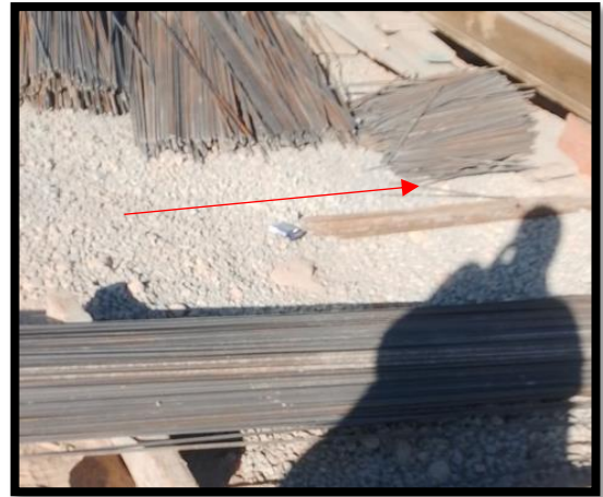
Figure.1.10. Poste de ferrailage
