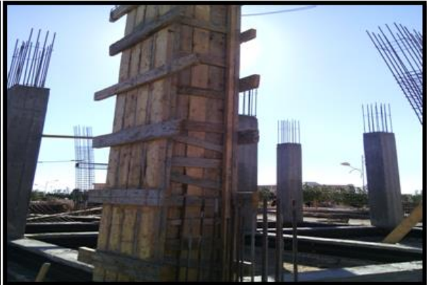
Figure.1.49. Coffrage du poteau.
