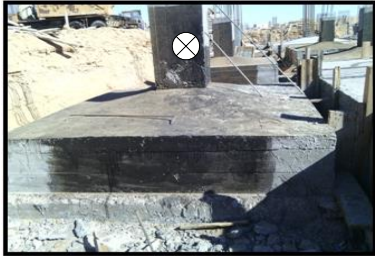
Figure.1.42. Mauvais badigeonnage.
