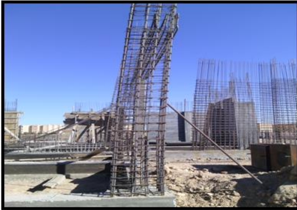
Figure.1.48. Ferrailage du poteau.
