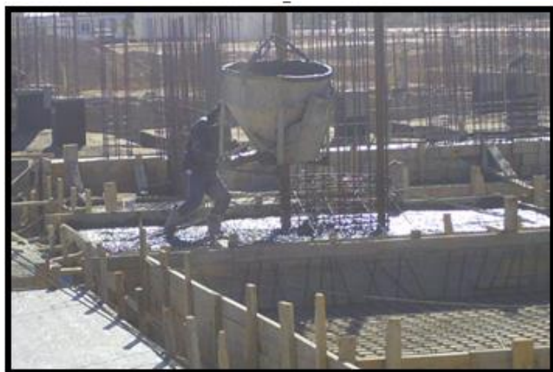
Figure.1.39. Coulage de semelle par la grue.
