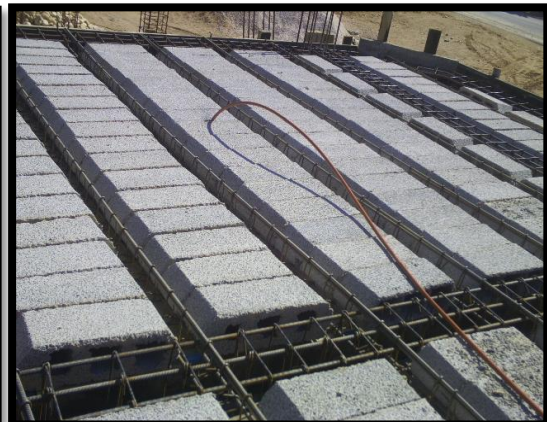
Figure.1.57. pose du treillis soudés.
