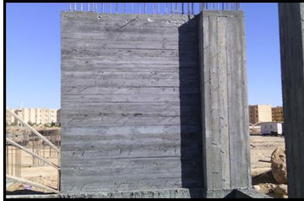
Figure.1.55. Décoffrage de voile.
