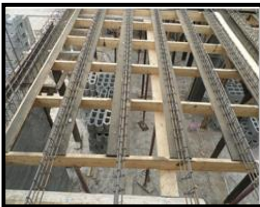
Figure.1.56. Le coffrage des poutrelles.
