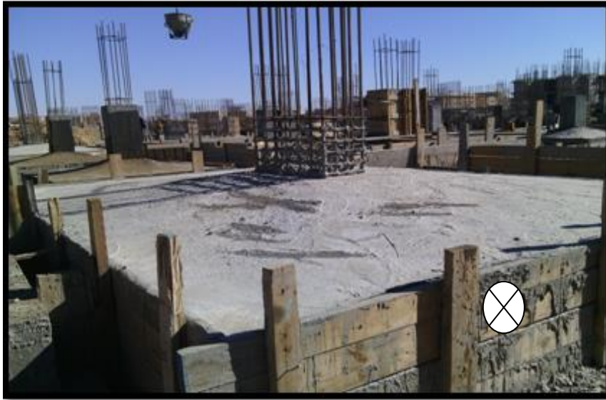
Figure.1.40. fin de coulage
