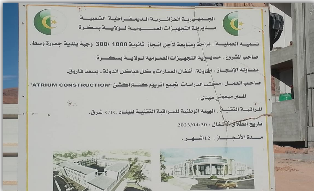
Figure.1.3 Panneau de chantier
