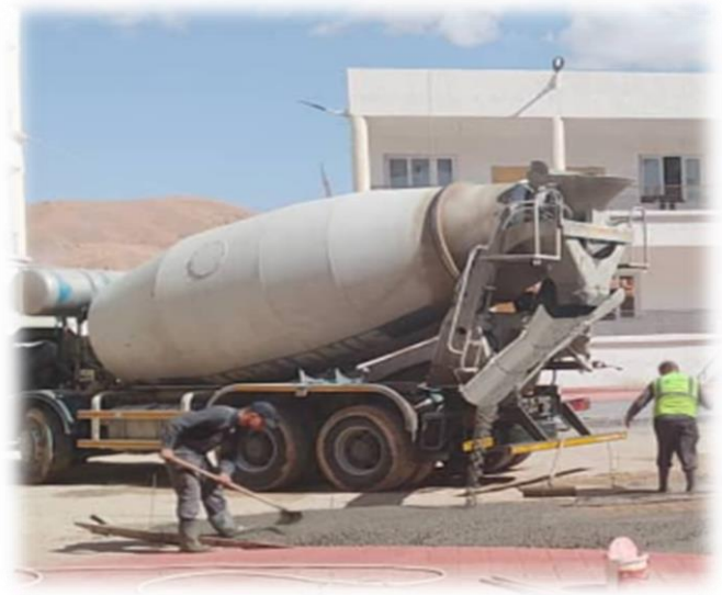
Figure.1.9. camion destiné pour le transport de l'eau. Figure.1.10 Camion toupie (Malaxeur)
