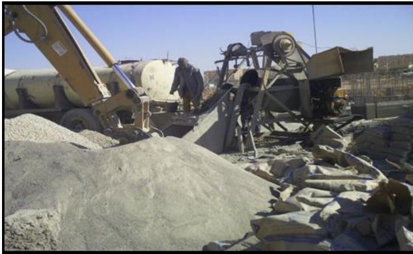
Figure.1.18. Espace de préparation du béton.
