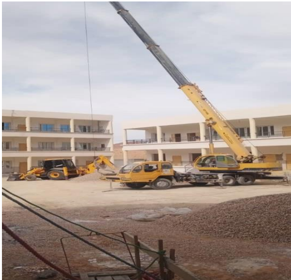
Figure.1.5. La grue de chantier Pour transporte de béton ET chargeur pour les remblais ou chargement.
