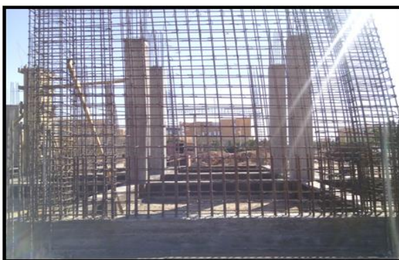
Figure.1.53. Ferrailage de voile.
