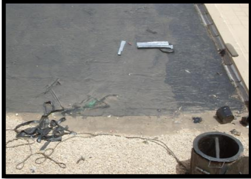
Figure.1.64. Badigeonnage de la terrasse
