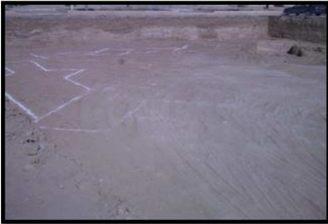
Figure.1.32. Réalisation de piquetage.
