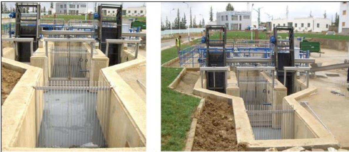
**Figure IV.5.** Opération de dégrillage.
