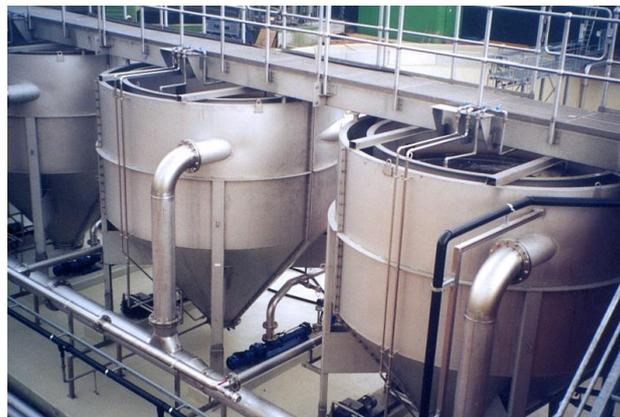
Figure IV.8. Dessableur-dégraisseur circulaire
