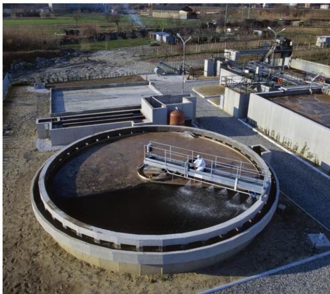
**Figure. IV.10** : Bassin décanteur
