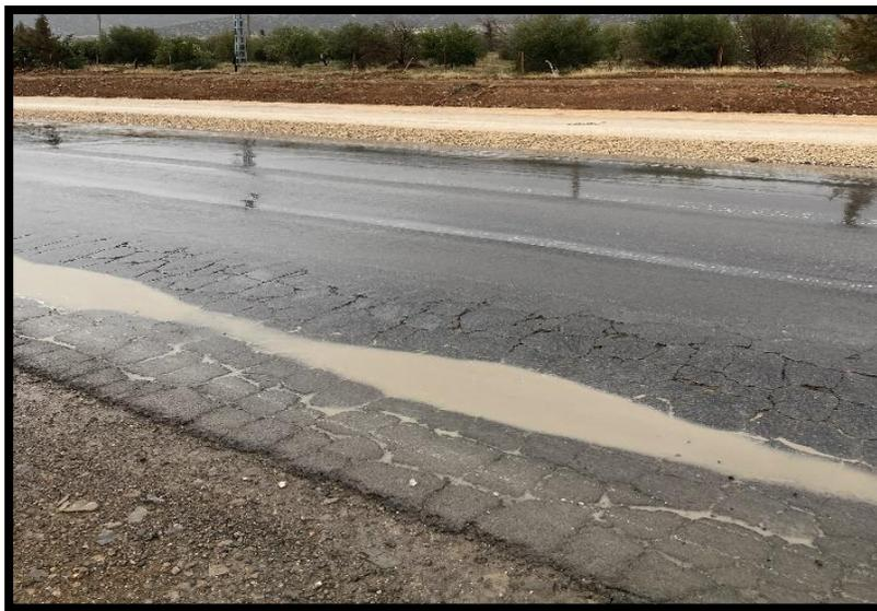
**Figure I.9:** Dégradation de la Route Existante
