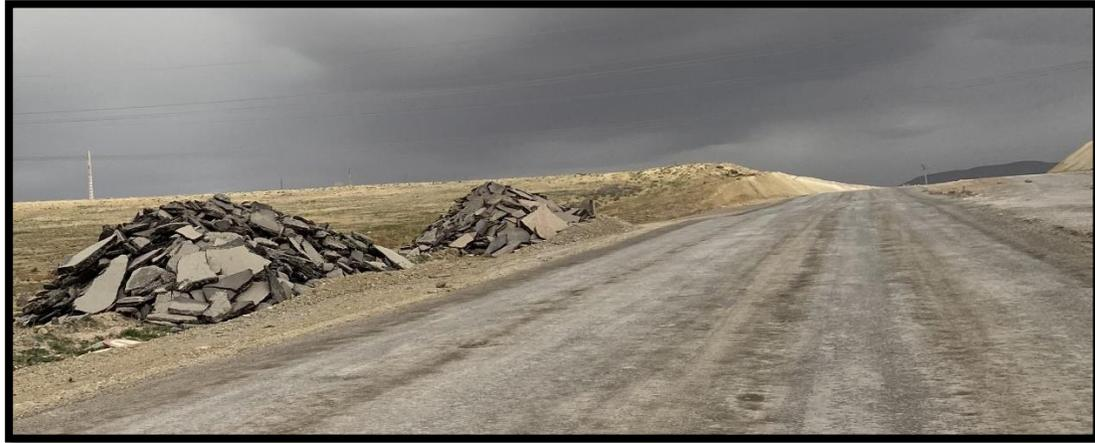
**Figure I.8:** Scarification de la Chaussée
