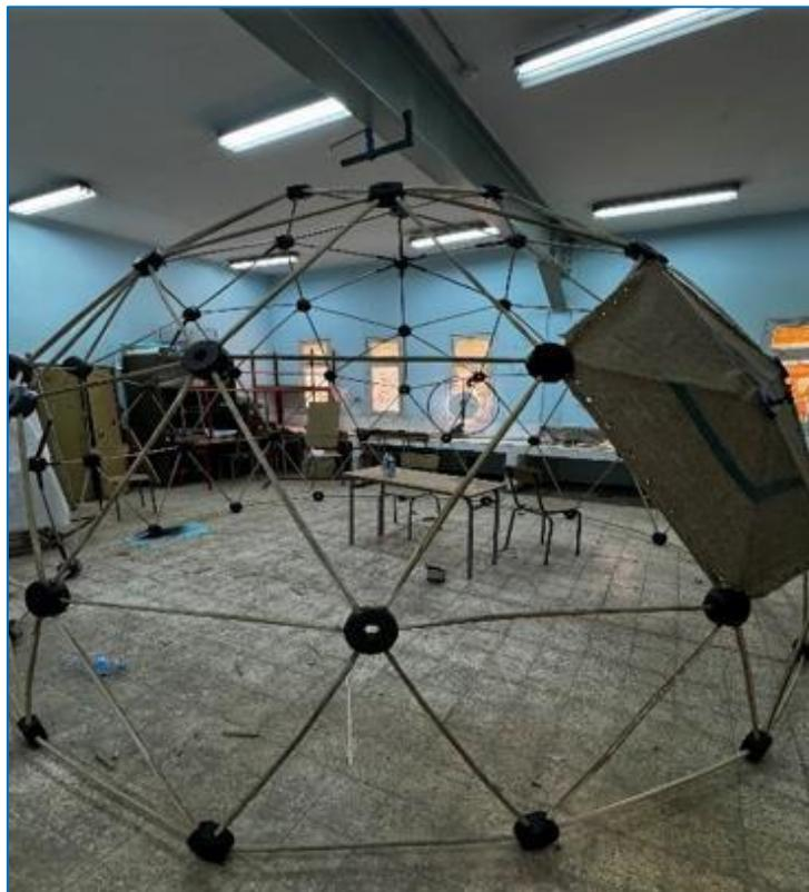
*Figure 3.20* : l'installation de la couverture.
