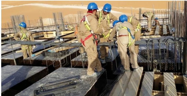
**Figure 22 :Coffrage et Ferrailage des poutres**
