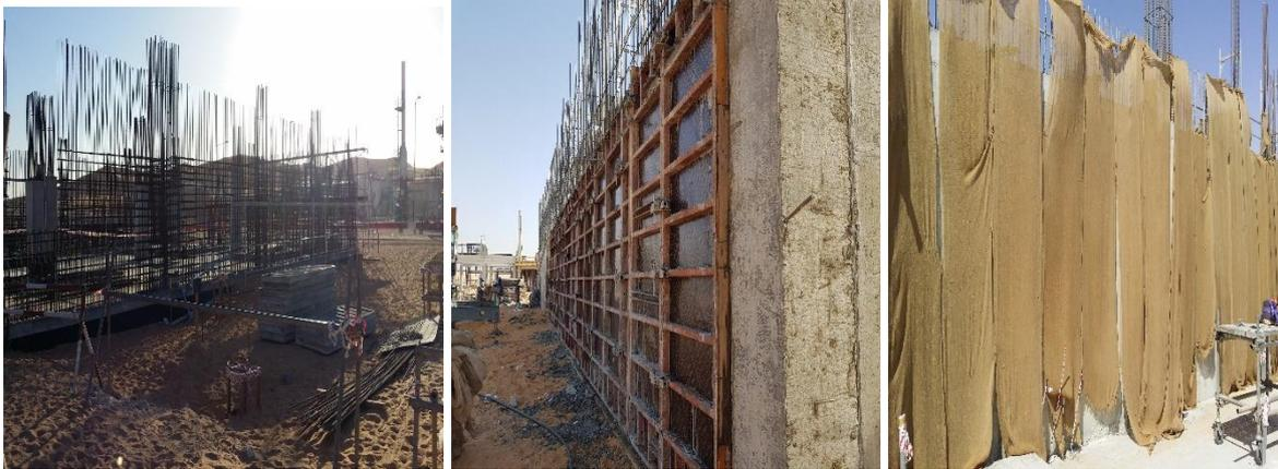
**Figure 21 : Ferrailage, Coffrage et coulage des voiles**
