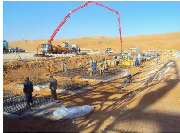
**Figure 18 : Ferrailage, Coffrage et Coulage des Fondations**
