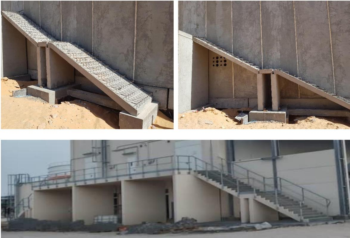
**Figure 24 : Montage des Escaliers Préfabriqué**
