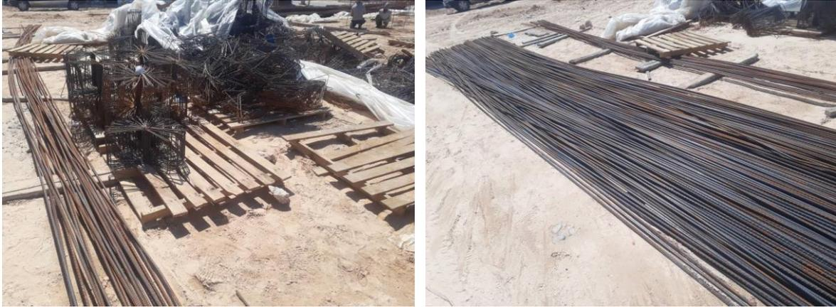
**Figure 12 : Stockage des armatures**
