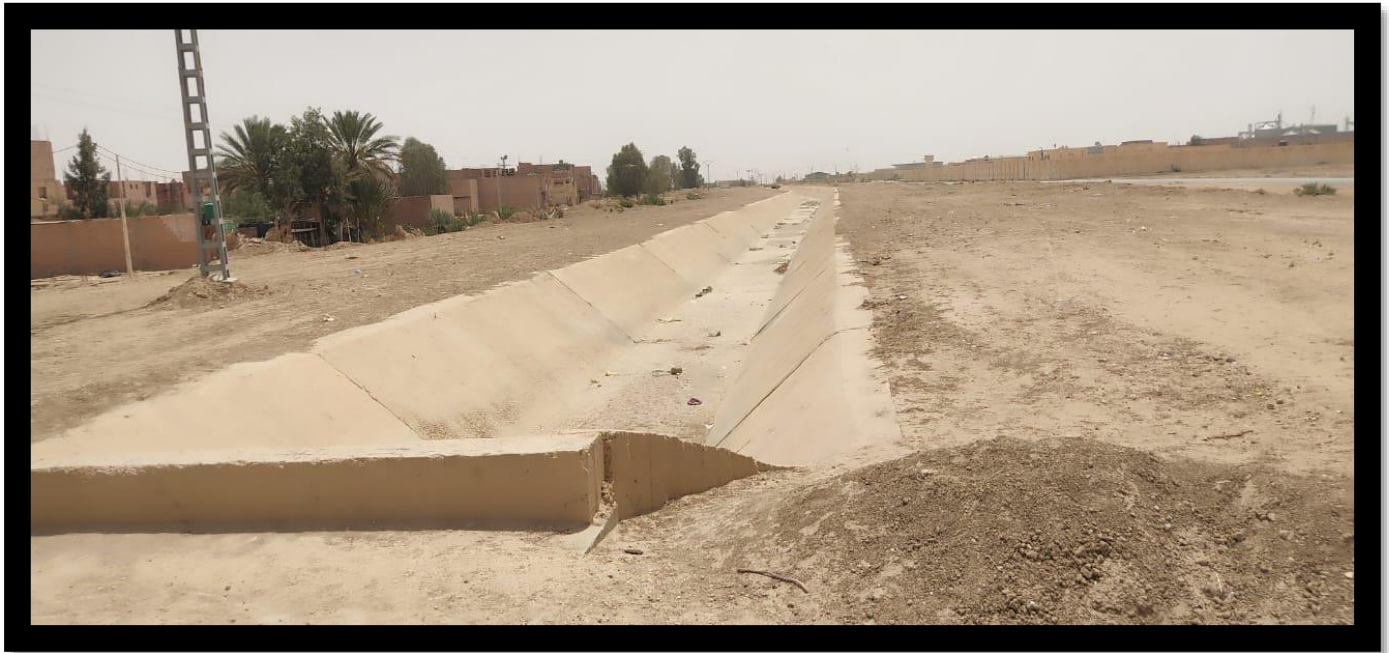
الصورة رقم (03): ساقية مصنوعة من الاسمنت المسلح في وسط المدينة
