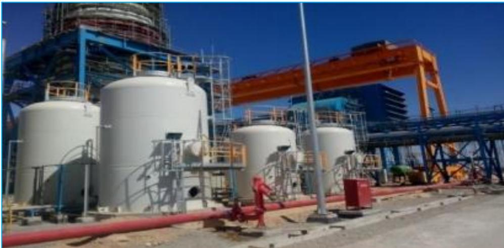
*Figure I.4* : Station d'air comprimé.
