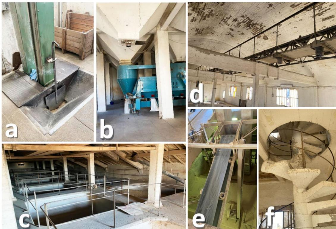
Figure 4-30: Photos intérieures des silos à grains de Sétif en 2022. a- L'élévateur au rez-de-chaussée des silos carrés. b- Fond du silo carré (vanne de décharge). c- Passerelles en porte-à-faux au 3e étage des silos carrés. d- Transporteur sous plafond des silos cylindriques. e- Élévateur des silos cylindriques. f- Escalier des silos cylindriques.
