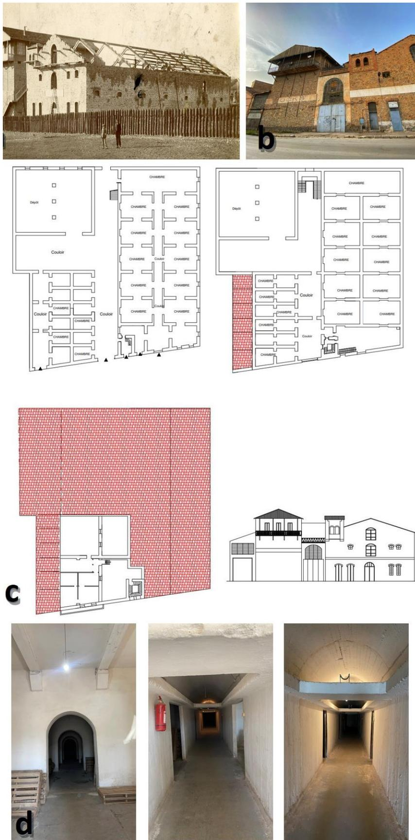
Figure 4-20: Magasin à blé de la Compagnie Algérienne. a- Image historique du bâtiment 1909. Source : Revue Le Béton Armé. b- L'état actuel du bâtiment en 2022. c- Plans des RDC, 1er et 2e étage en 2022 et Façade principale du bâtiment. d- Photos intérieures sur les différentes pièces de stockage.
