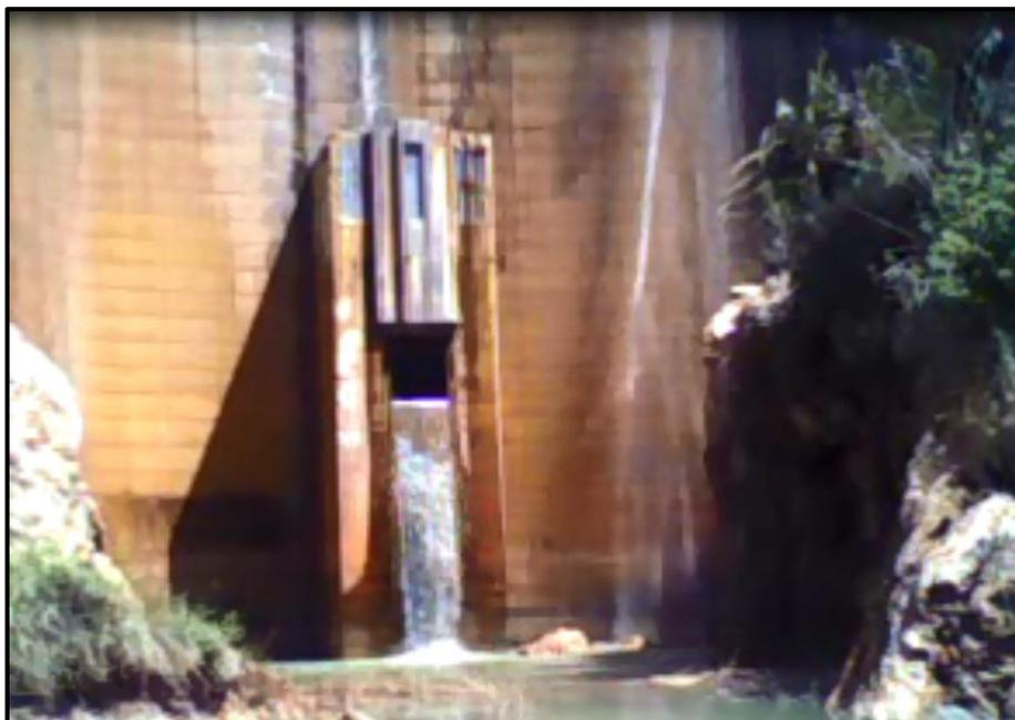
**Figure 26 : Déversement d'une crue accompagné d'une opération de vidange de fond**
