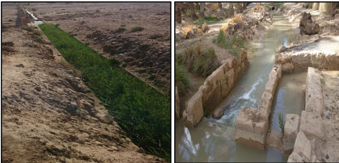
**Figure 83 : Photo de gauche : canal mal entretenu. Photo de droite : Répartiteur en terre mal entretenu au niveau de la seguia**
