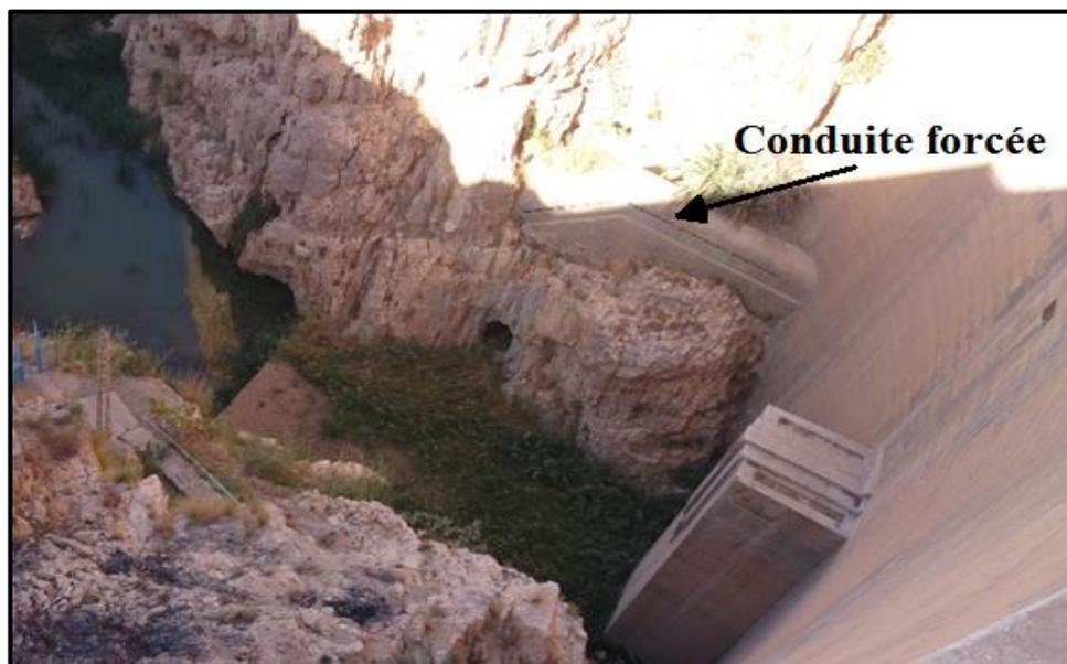
**Figure 39 : Conduite forcée pour l'irrigation**
