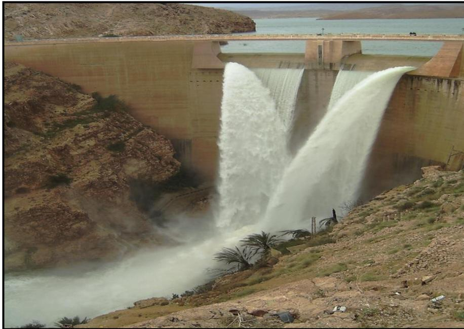
**Figure 25 : Evacuateur de crue du barrage de Fom El Gherza en plein déversement**
