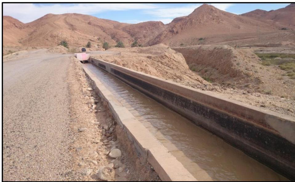
**Figure 41 : Canal d'irrigation principal à ciel ouvert**
