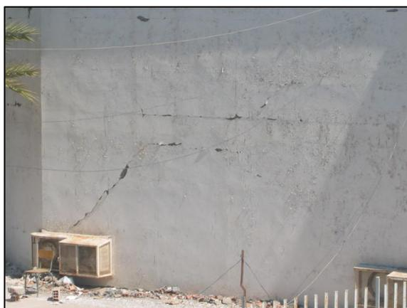
Fig. 8.8. Fissuration et dislocation des panneaux en maçonnerie
