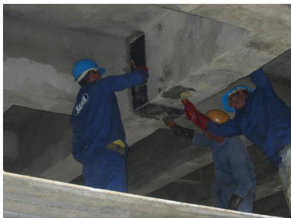
Fig. 7.4. Mise en place de la résine
