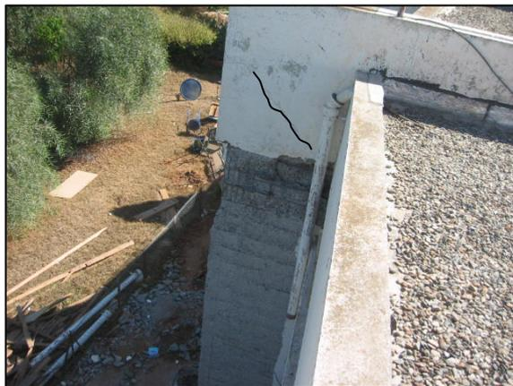
Fig. 8.7. Fissurations superficielles des noeuds
