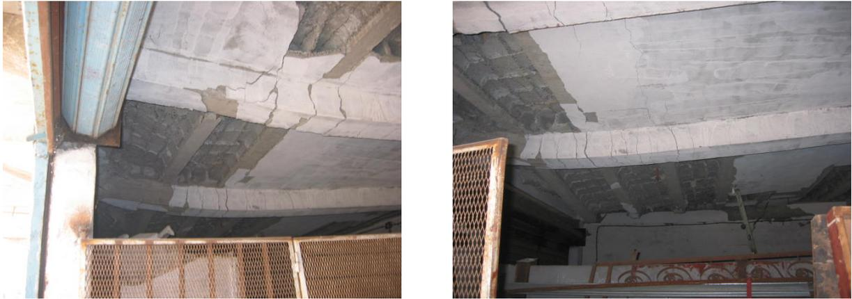
Fig. 2.13. Fissurations excessives de deux poutres d'un plancher dû à la chute des panneaux en maçonnerie de l'étage au dessus (séisme de Boumerdes 2003)
