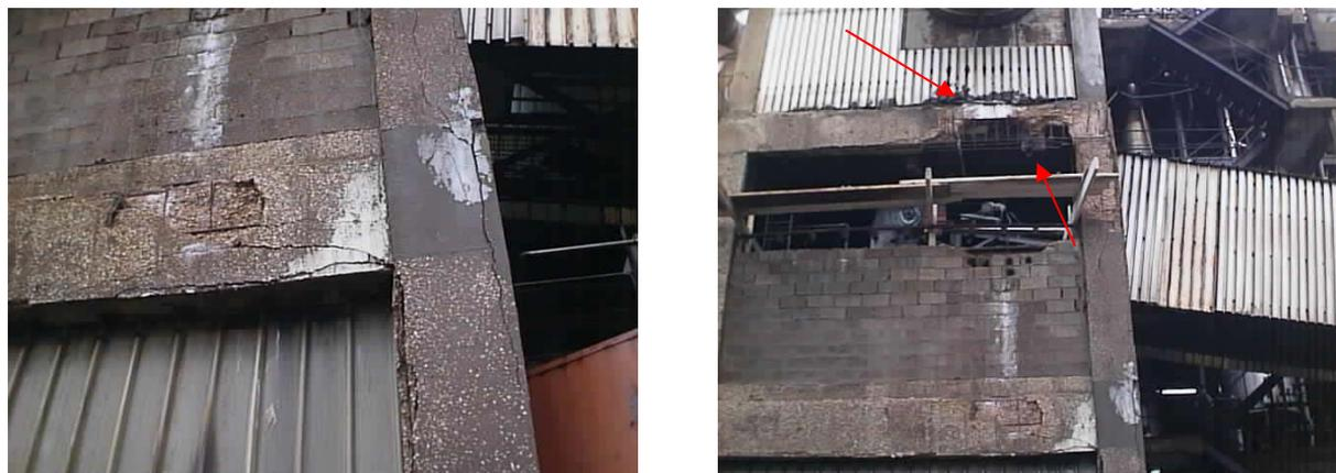
Fig. 2.10. Dégradation des poutres d'une structure du complexe de fabrication d'engrais (nitrate d'ammonium) Annaba [CHI 02]
