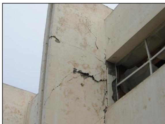
Fig. 8.3. Fissuration et éclatement du béton des poteaux courts
