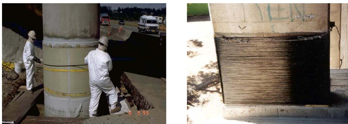
Fig. 1.3. Confinement de colonnes de ponts par matériaux composite [KAR 00]
