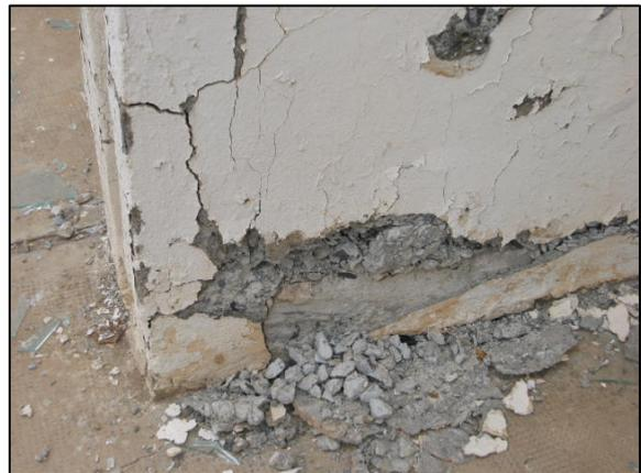
Fig. 8.5. Fissuration et éclatement de l'enduit des pieds de poteaux
