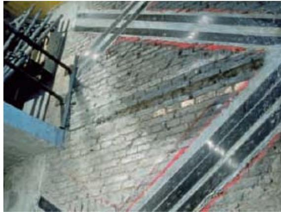
Fig. 1.4. Réhabilitation d'un mur en maçonnerie (Suisse) [NET 03]
