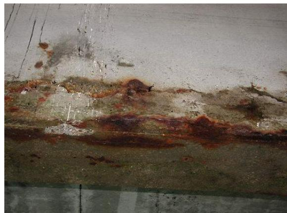
Fig. 2.2 Poutre située en bord de mer sous de l'agression des chlorures [NET 01]
