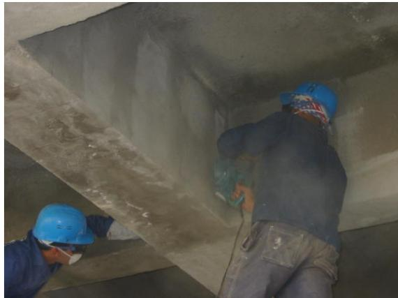
Fig. 7.1 Ponçage de la surface
