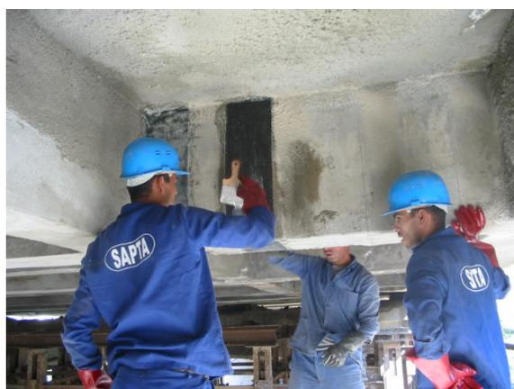
Fig. 7.5. Mise en place du composite
