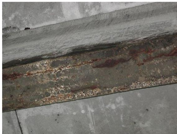
Fig. 2.7. Fissuration d'une poutre en béton exposée aux eaux de mer [NET 01]
