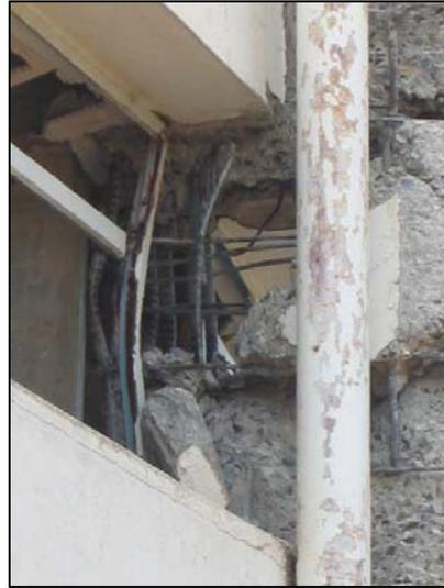
Fig. 8.4. Eclatement du béton et flambement des aciers
