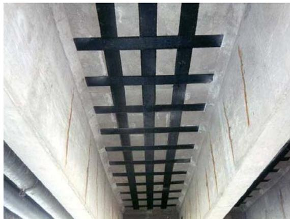
Fig. 1.5. Renforcement d'une dalle de pont [KAR 00]
