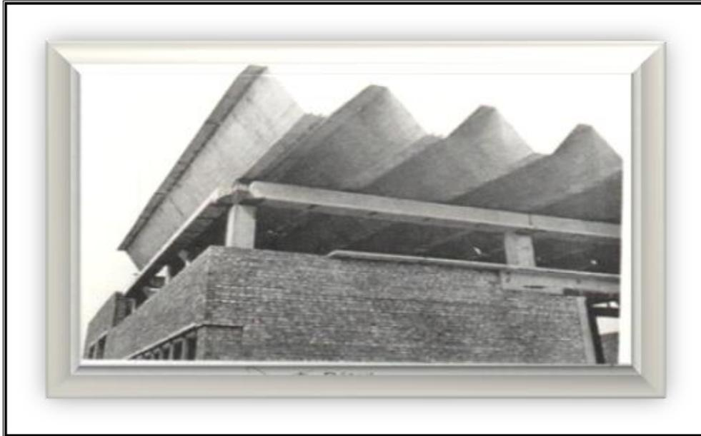
**Photo 7** : Le béton de sable dans la préfabrication
