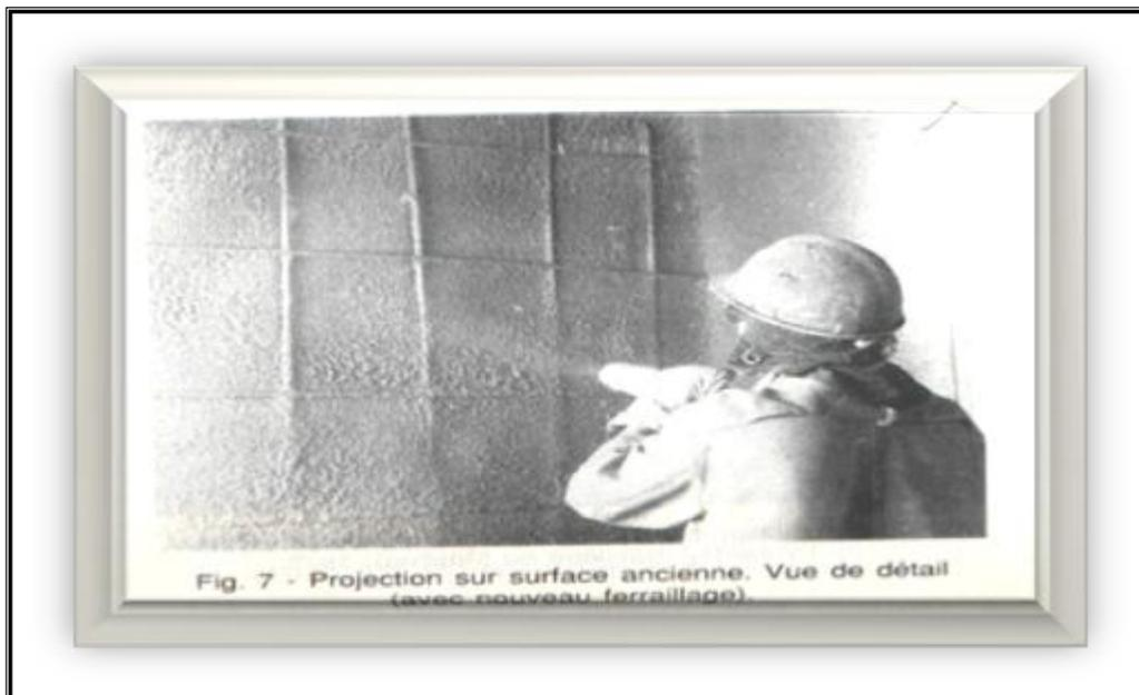
**Photo 4** : Le béton de sable en projection (Projection sur surface ancienne. Vue de détail (avec nouveau ferrailage) [5]
