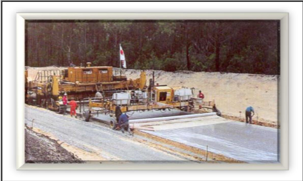
**Photo 9:** Déroulement d'un film polyane (cure) [1]
