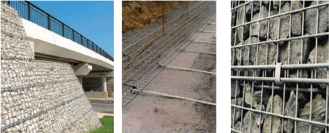
Figure 1.8. Parement treillis soudé en acier.
