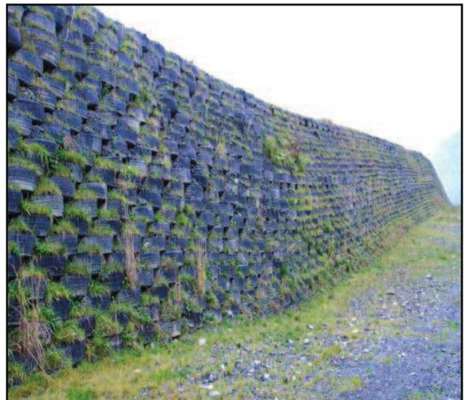
Figure 1.11. Murs avec un parement en Pneus.
