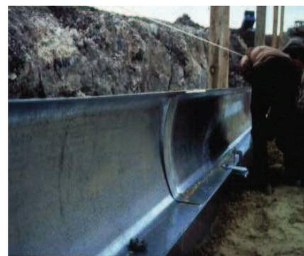
Figure 1.7. Parement semi-elliptiques en acier.
