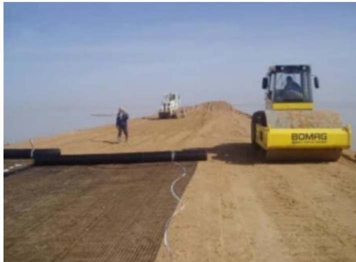
Figure 2-6. Installation of a geogrid (Berrabah et al 2020).
