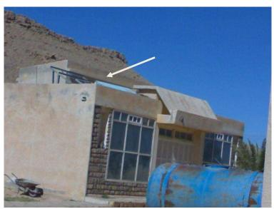
Photo (II-I-11)- ouvertures en hauteur, pour captage solaire au séjour.
