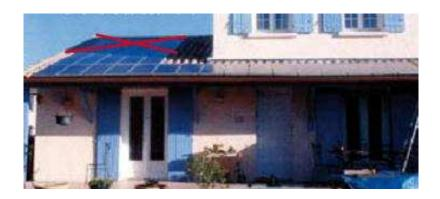
Fig. (I-III-1)- installation du capteur PV dans un endroit masqué.
