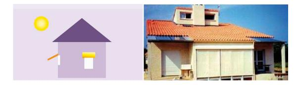
Fig. (I-III-16)- intégration des capteurs solaires en auvent et brise soleil sur les ouvertures.
