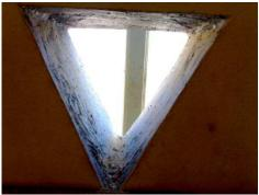
Photo (II-I-6)- fentes du mur Trombe permettant la circulation de l'air chaud en hiver.
