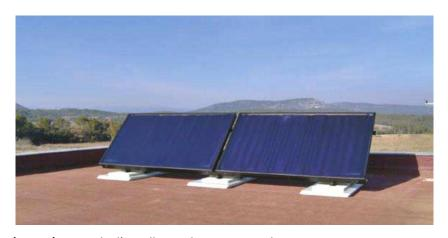
Fig. (I-III-19)- exemple d'installation des capteurs solaires sur une toiture terrasse.
