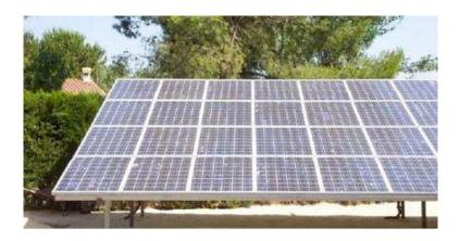
Fig. (I-III-24)- exemple d'installation des capteurs solaires sur le sol.
