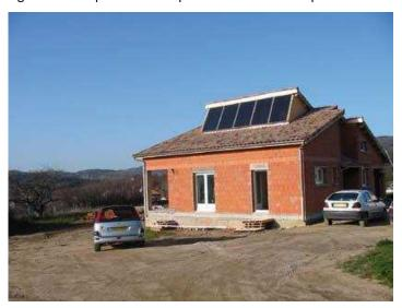
Fig. (I-III-10)- intégration du capteur sur une toiture en pente d'un volume du bâtiment.
