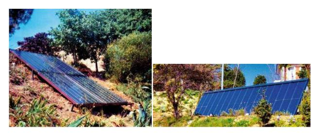
Fig. (I-III-25)- installation des capteurs solaires sur le sol.
