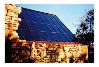
Fig. (I-III-28)- exemple d'installation des capteurs solaires sur une dépendance.
