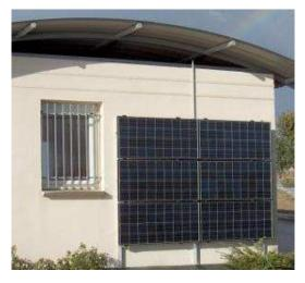
Fig. (I-III-15)- intégration des capteurs solaires sur les allèges.
