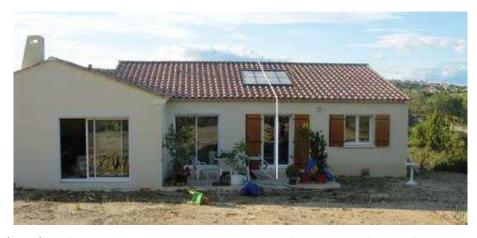
Fig. (I-III-6)- intégration du capteur sur une toiture inclinée respectant l'axe de l'ouverture.
