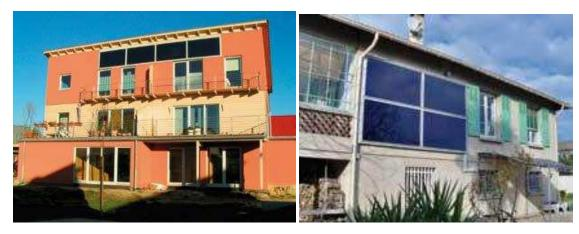
Fig. (I-III-20)- exemple d'installation des capteurs solaires sur la façade comme composant architectural.
