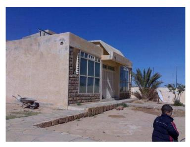
**Photo (II-I-10)-** vue du coté Sud, définition de 3 espaces : le séjour familial avec la serre au centre et les chambres de part et d'autre avec leurs ouvertures et mur trombe.
