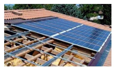
Fig. (I-III-12)- modes d'intégration du capteur sur une partie d'une toiture en pente.
