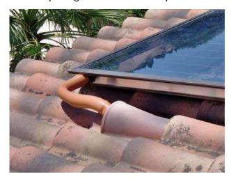
Fig. (I-III-11)- intégration des systèmes et accessoires du capteur sur une toiture en pente.
