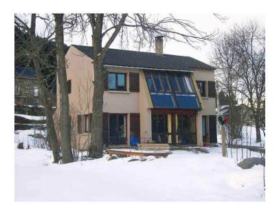
Fig. (I-III-22)- exemple d'installation des capteurs solaires sur un volume du bâtiment.
