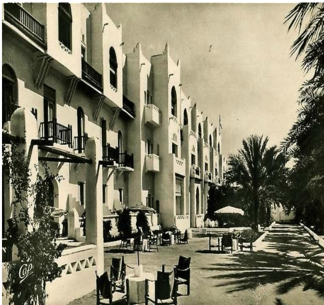
Figure I.8 : Hôtel transatlantique Biskra, architecte Guiauchain Jacques
