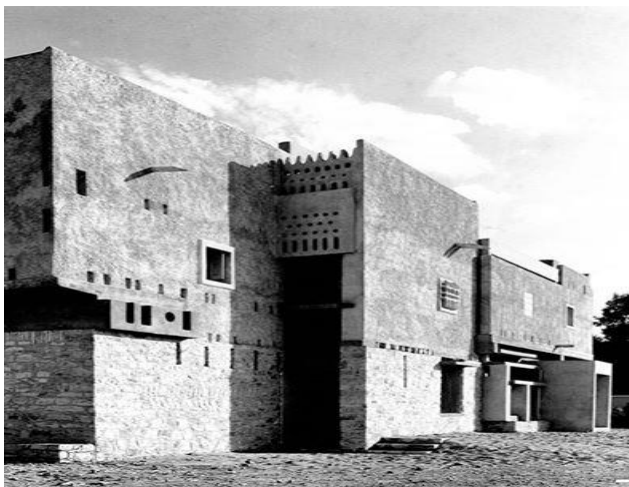
Figure I.27 : André Ravéreau Hôtel des postes de Ghardaïa 1966-1967
