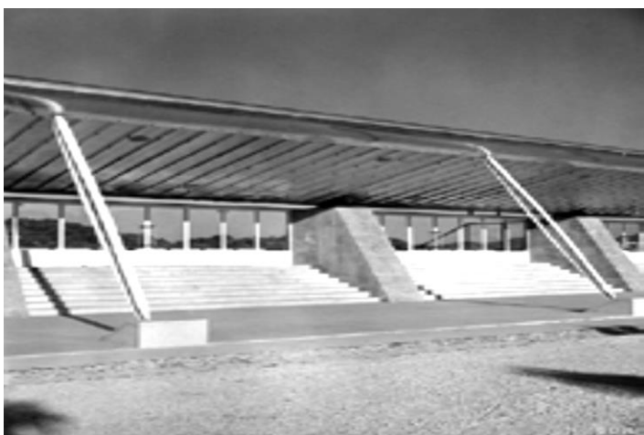
Figure II.1 : Stade municipale d'Aix- en- Provence 1949 Source : www.fernandpouillon.com (consulté le 29.02.2017)
