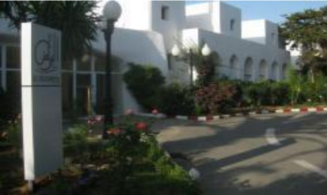
Figure IV.58: Une vue sur la façade sud de l'hôtel El Riadh
