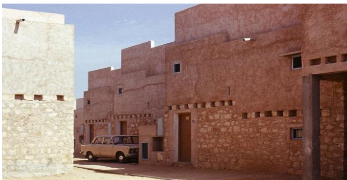
Figure I.40: Ouvertures aux dimensions réduites au Village de terre Logements économiques à Sidi Abbaz, Source: www.aladar-assoc.fr (consulté le 19.02.2015)
