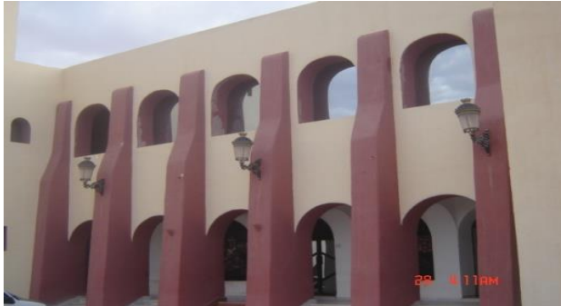
Figure II.11 : Les piliers et les contres forts dans l'hôtel Rustoumide Ghardaïa
