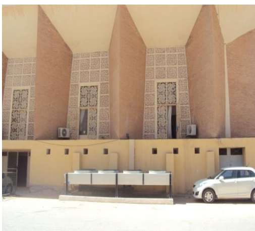
Figure I.43: Vue sur les grandes ouvertures des bureau de la préfecture d'ouargla protégés par des mouchrabia
