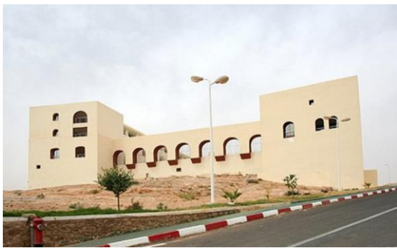
Figure IV.42 : Vue sur la façade Ouest de l'hôtel Rustumides
