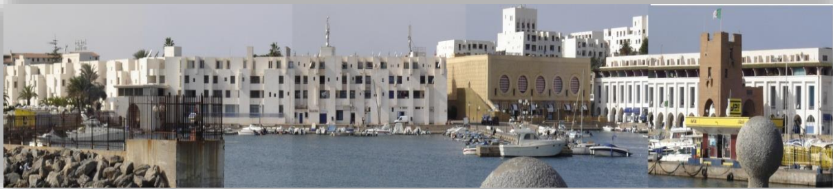
Figure IV.62 : Vue sur les façades de l'hôtel El Marsa
