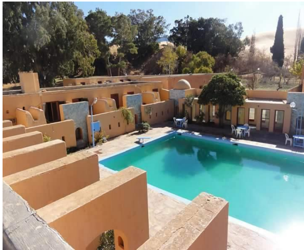
Figure VI.18 : Vue sur les murs épais qui composent la façade écran de l'hôtel Mekther
