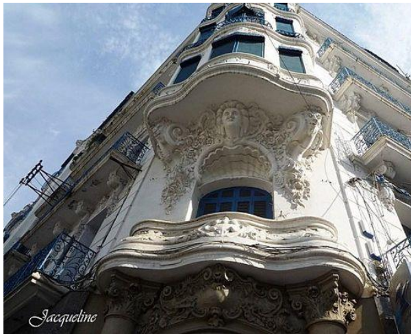
Figure I.3 : Immeuble urbain de la fin du XIX e siècle Architecture "classicisante", Alger Source : (Jaqueline, 2009 )
