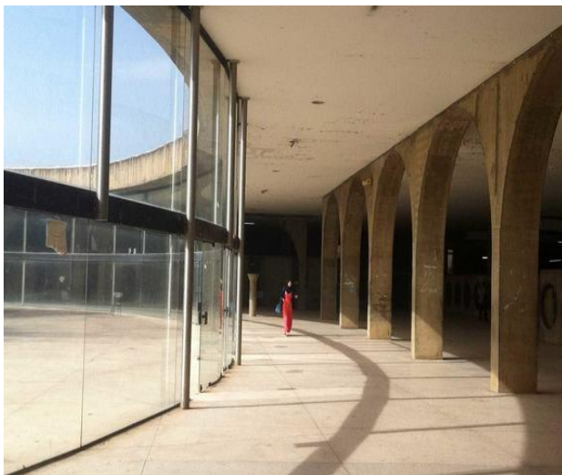
Figure I.37 : Passage de La faculté d'électronique et d'informatique, Université des sciences et de la technologie Houari -Boumedienne, Bab-Ezzouar, Alger ,1974 ,Architecte :Oscar Niemeyer Source: www.archnet.org (consulté le 15.10.2017)
