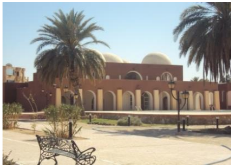
Figure IV.13 : Vue sur la façade nord de l'hôtel Maheri
