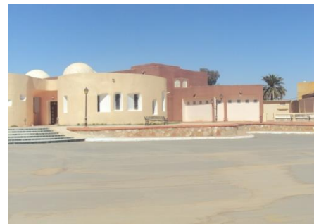
Figure V.14 : Vue sur la façade principale de l'hôtel Maheri
