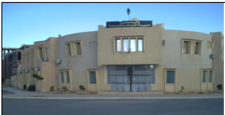
Figure 5.17 : Direction des mines à Biskra. Source : Auteur, 2017.
