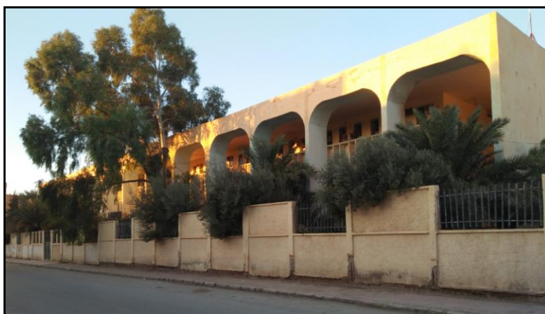
c. Vue du bâtiment.
