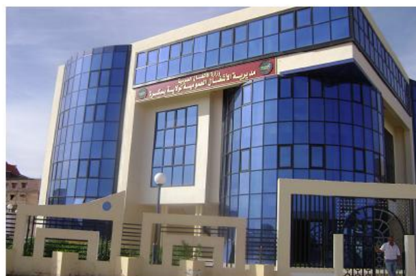
c. Vue du bâtiment.
