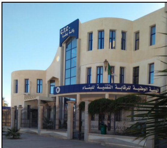
Figure 5.30: Bâtiment du CTC de Biskra. Source : Auteur, 2017.
