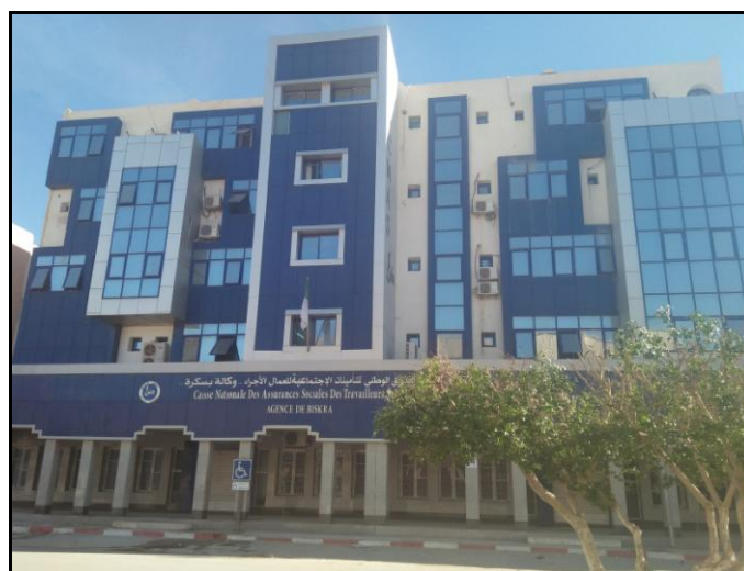
Figure 5.26: Siège de la CNAS (après traitement des façades) de Biskra.
