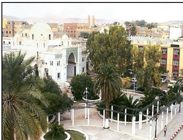
Figure 5.2 : Vue du Centre ville de Biskra.
