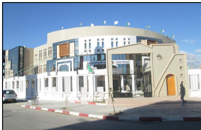
c. Vue du bâtiment.
