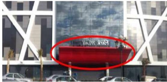
Figure 26 : l'auvent au métallique
