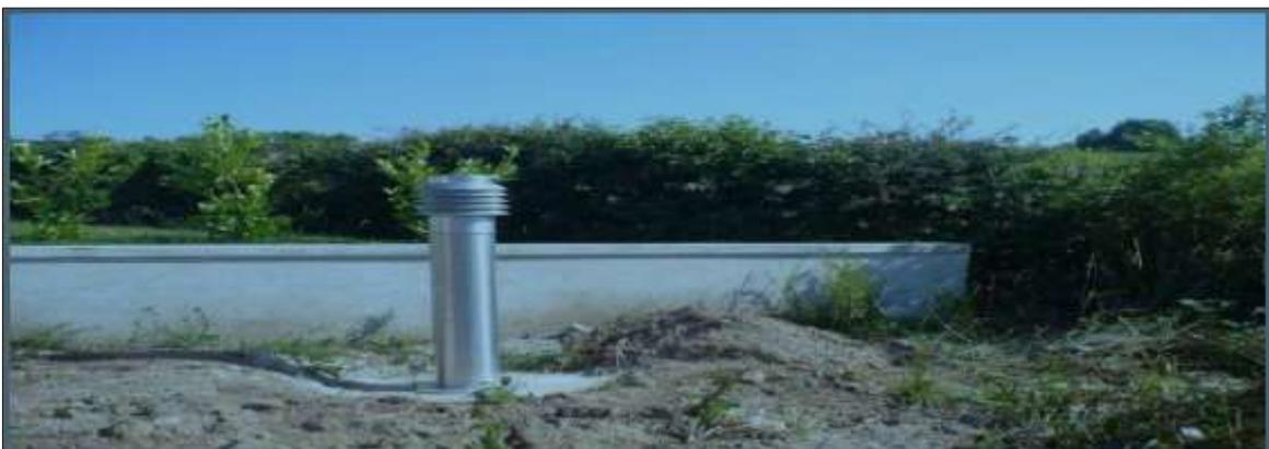
**Figure. I.15:** La prise d'entrée de l'air neuf [10].
