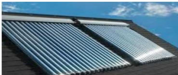
Figure .1.5: capteur sous vide. [3]
