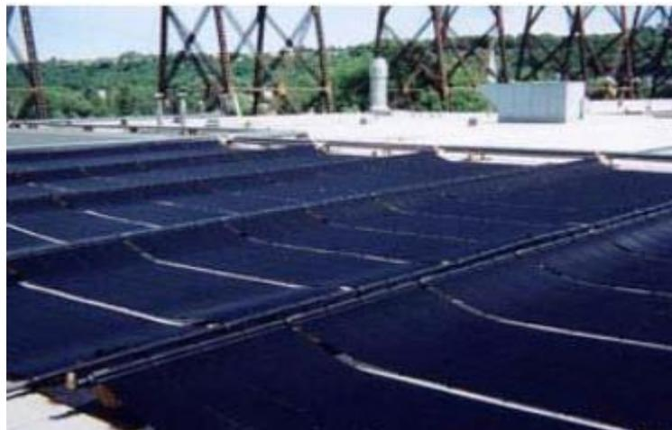
**Figure .1.6.** Capteurs plans sans vitrage. [3]
