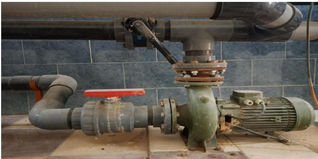
**Figure 3.3** : Pompe centrifuge axiale
