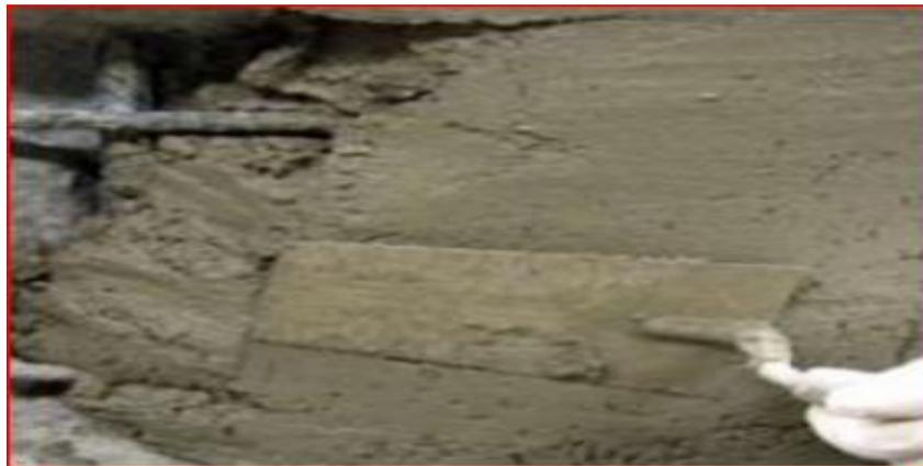
Photo n°23 : Méthode 2 : application manuelle de mortier
