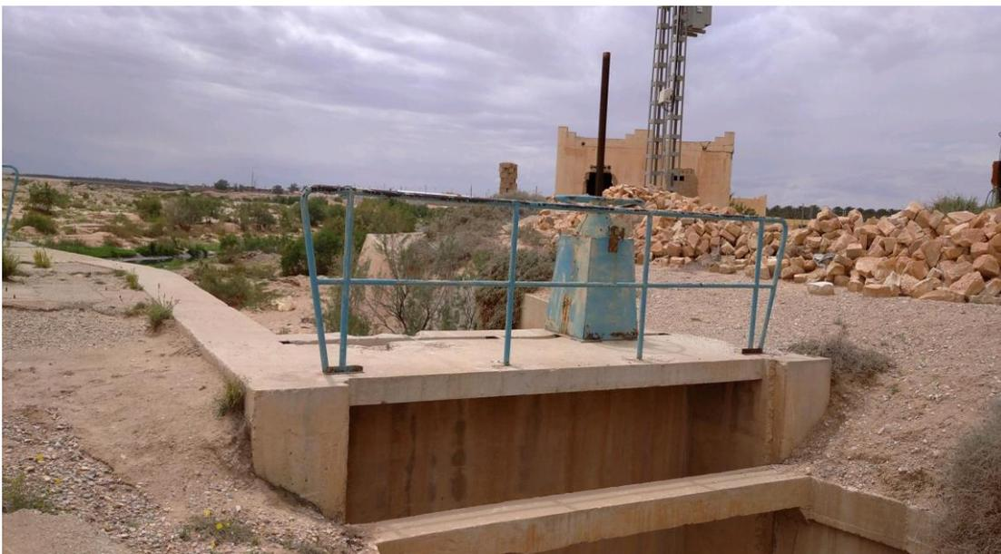
**Photo n° 13 : canal de distribution, irrigation (LOUGHRAICHL.Y,2020)**
