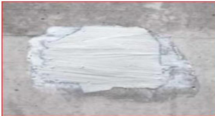
**Photo n°26 : Méthode 5 : colmatage des fissures, des vides**
