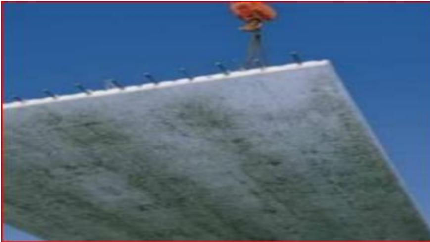
**Photo n°25 : Méthode 4 : remplacement d'éléments**
