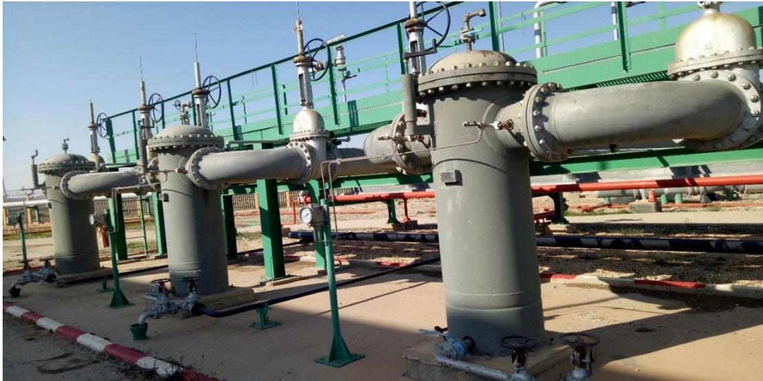
Figure 7: Les filtres entrée station
