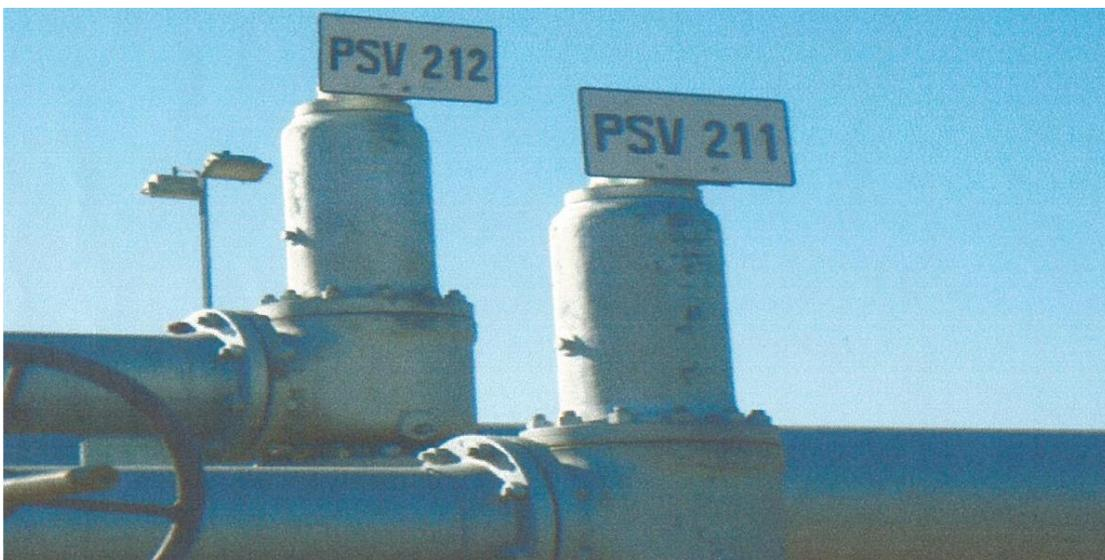
**Figure 6: Les soupapes entrées station**
