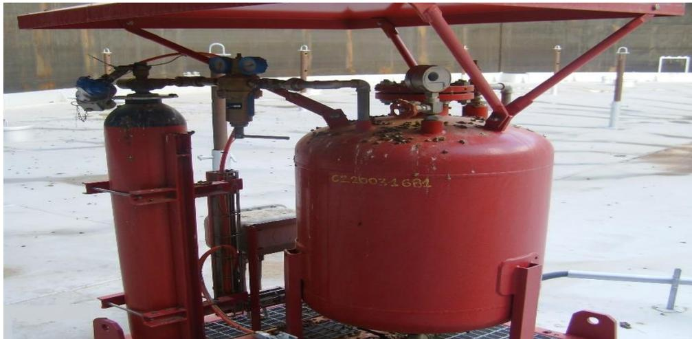
**Figure 20 : Erogateur à mousse**
