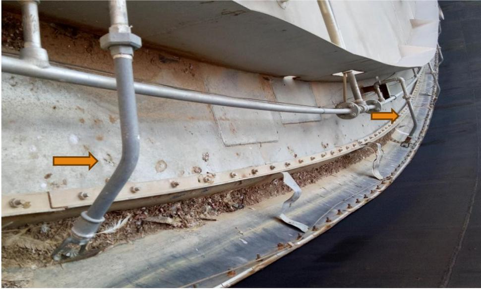
**Figure 19 : Erogateur eau (sprinkler)**
