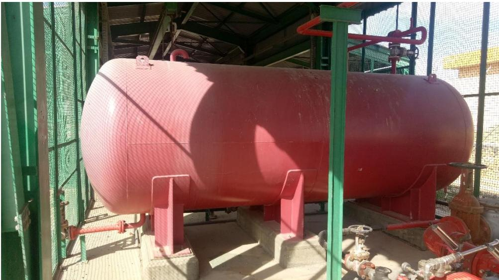
**Figure 16 :** Unité de stockage et dosage d'émulseur
