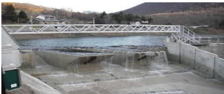
**Figure (I-27) :** Piano Key Weir sur barrage Goulours (EDF – France).
