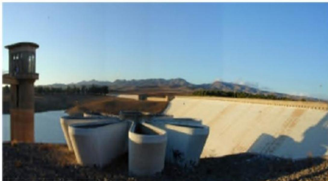
**Figure (I-17) :** Evacuateur en puits marguerite.
