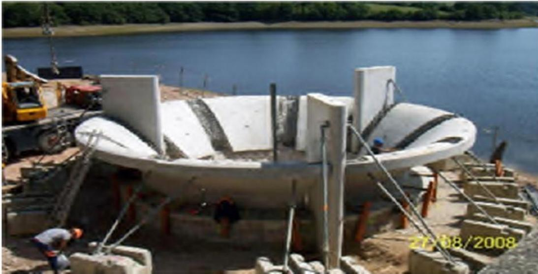
**Figure (I-16) :** Évacuateur en puits circulaire.
