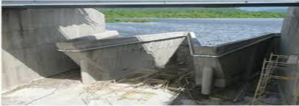
**Figure (I-25) :** Déversoir en labyrinthe du barrage de Song Mong (Viêtnam).
