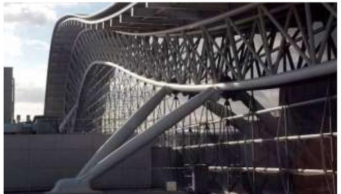
**Figure 18 1:** enveloppe porteuse en métallique
