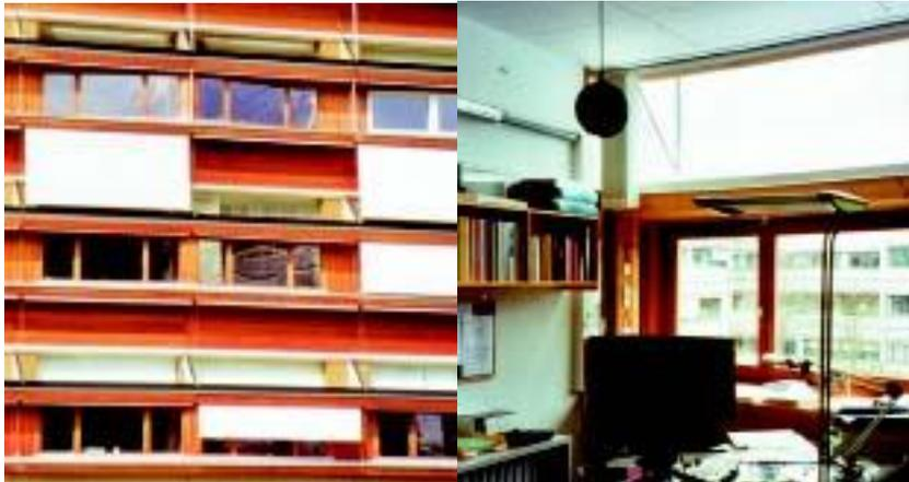
Figure : les vues extérieures et intérieures de la façade avec le plafond anidolique source : energieplus.2007
