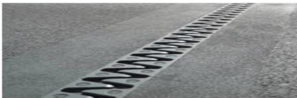
Figure 7.16: joint de chaussée FT150-Freyssine
