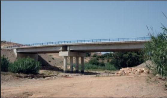
**Figure 7.10** : Pont à poutres à travées indépendantes en béton armé
