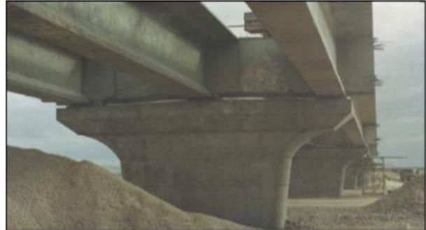
**Figure 7.11** : Pont à poutres à travées indépendantes en béton précontraint
