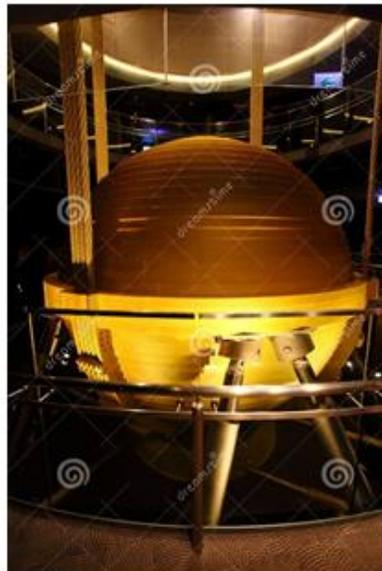
**Figure 1.10** : TMD pendulaire de 800 t dans un bâtiment de 508 m de hauteur (Taipei 101). [11]
