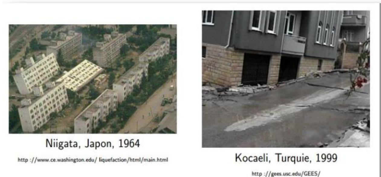
Figure 1-7 : Perte de portance du sol (rupture) sous une fondation.
