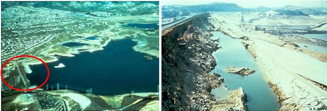
Figure 3-1 : Barrage de San Fernando avant et après le séisme de 1971[28].
