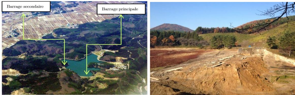
Figure 3-4 : Barrage Fujinuma avant et après le tremblement de terre de 2011(Wiki 2018).
