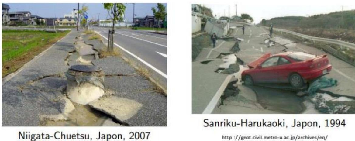
Figure 1-8 : Tassements post-sismiques et/ou Fissures en surface
