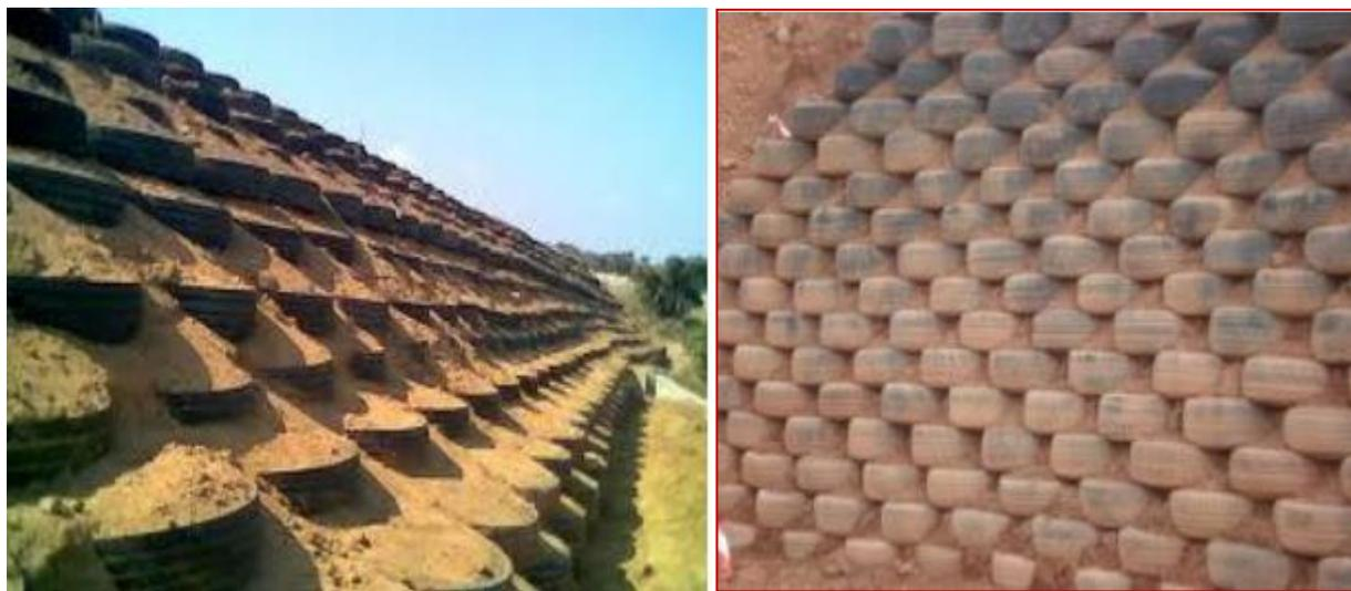
**Figure I-16: Mur en pneu sol.**
