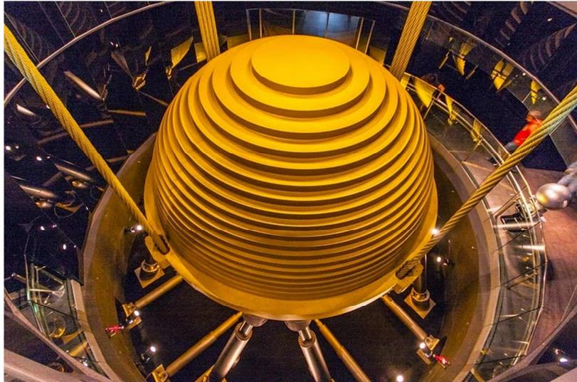
**Figure 1-10 :** Un TMD pendulaire de 800 tonnes dans un bâtiment de 508 m de hauteur (Taipei 101)
