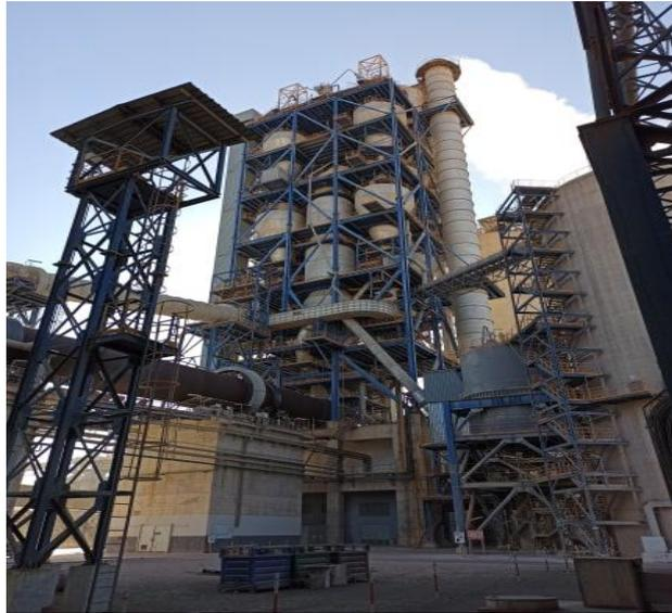
**Figure I.14** : Four rotatif et préchauffage
