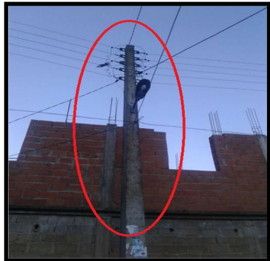
الصور رقم (27،28): عدم احترام ارتفاع الكهرباء.
