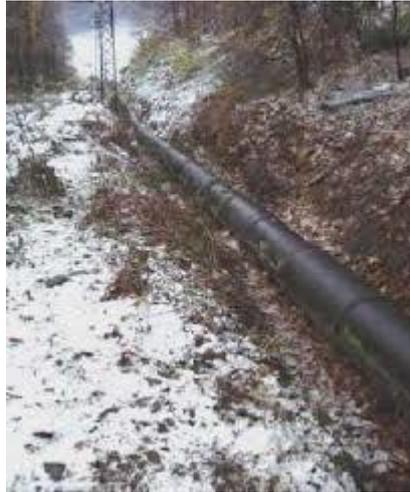
**Figure 2.6** : exemple de conduite forcée de conception rivetée.
