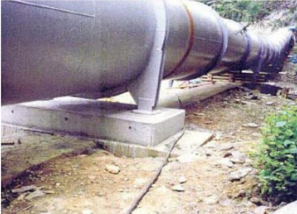
**Figure 2.1:** exemple de conduite forcée aérienne, avec ses appuis sur des pilettes et ces ancrages.
