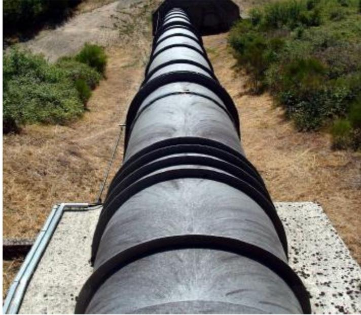
**Figure 2.9** : Structure de conception plus récente : conduites forcées soudées.
