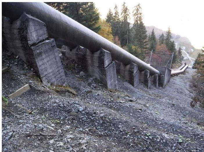
**Figure 2.4 :** Conduite forcée avec des blocs d'ancrage en béton.
