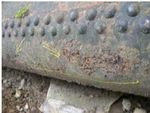
**Figure 2.7** : exemple de perte d'épaisseur localisée affectant les conduites forcées.
