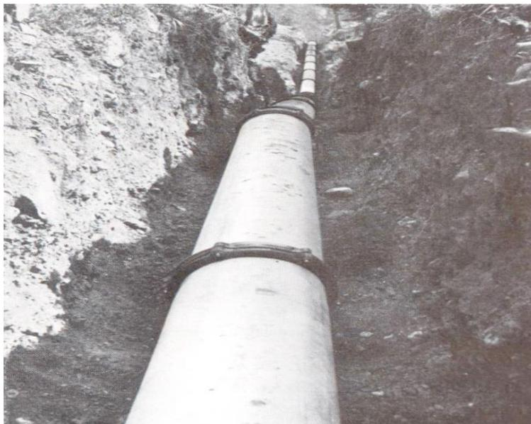
**Figure 1.10** : conduite forcée en tuyau d'éternit.
