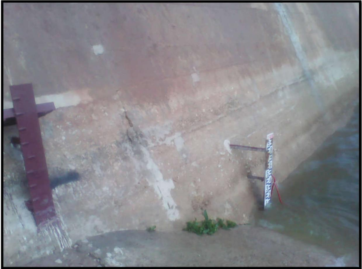
**Figure II.10 : Echelle limnimétrique du barrage Foum El Gherza**
