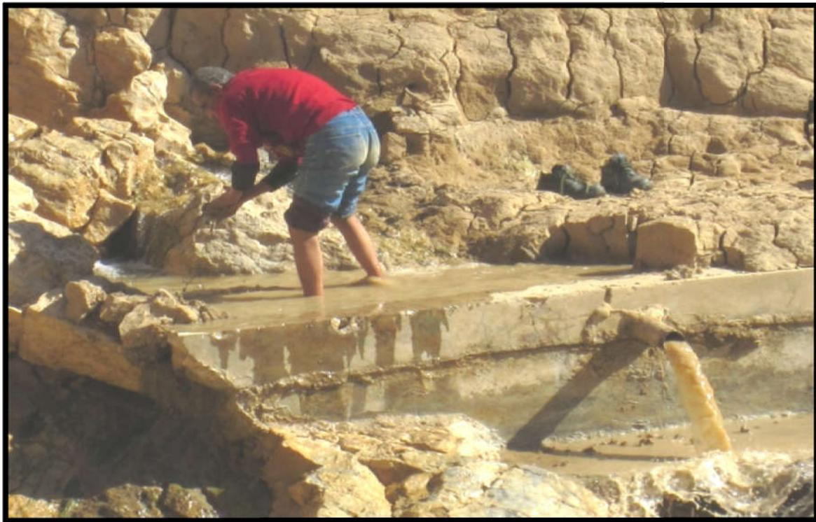
Figure III.11 : Nettoyage des bassins de mesure des fuites
