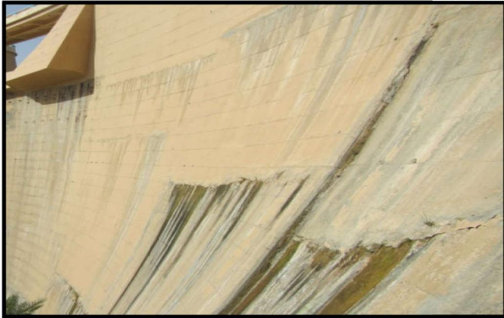
**Figure II.11 : Fuites aux niveaux des joints et opération d'étanchement de la voûte.**
