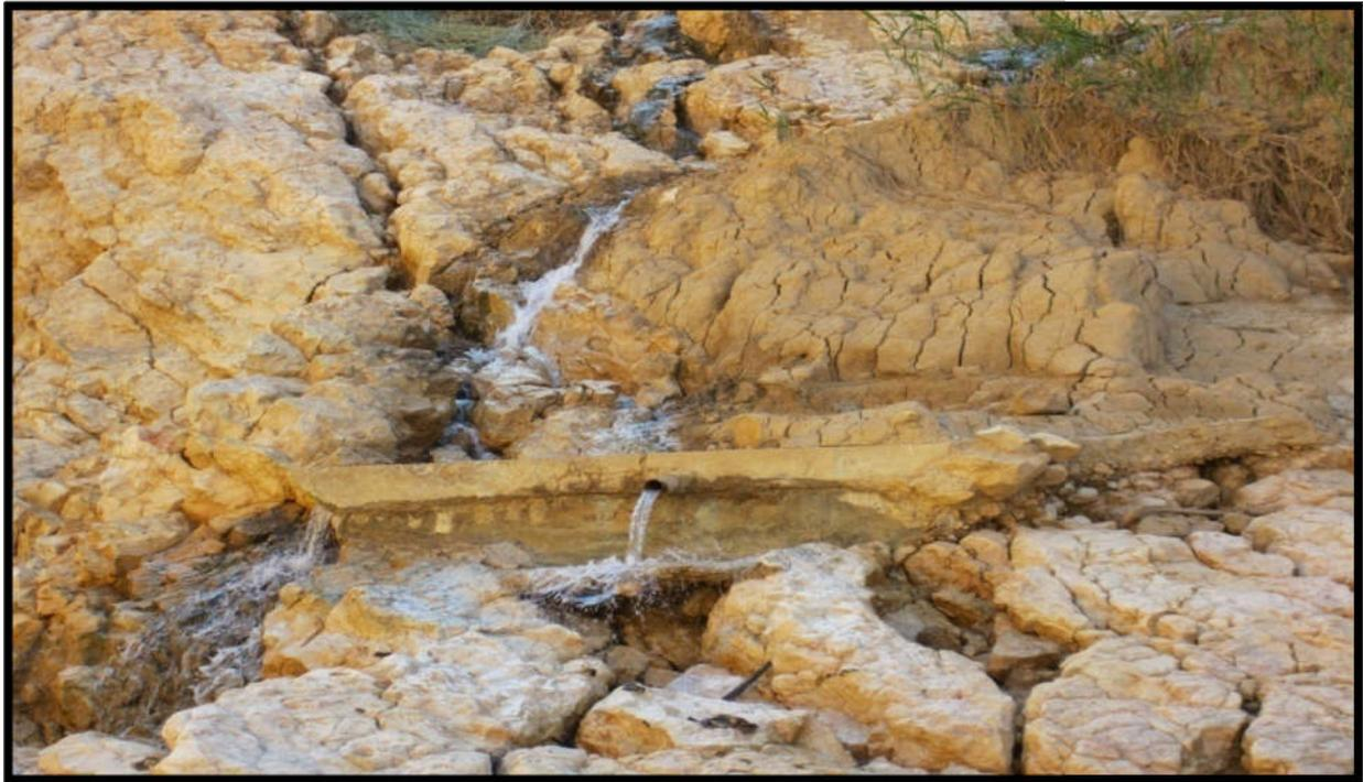
**Figure II.6 : Fracturation des appuis du barrage**
