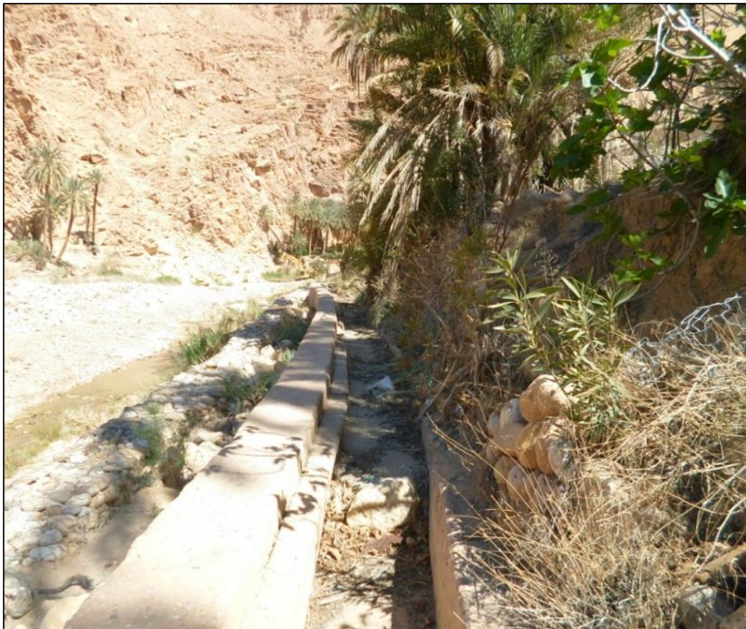
Figure (3.12) : partie seguia inferieur rive droite
