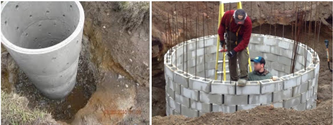
Figure IV.19 : Puits filtrants absorbant
