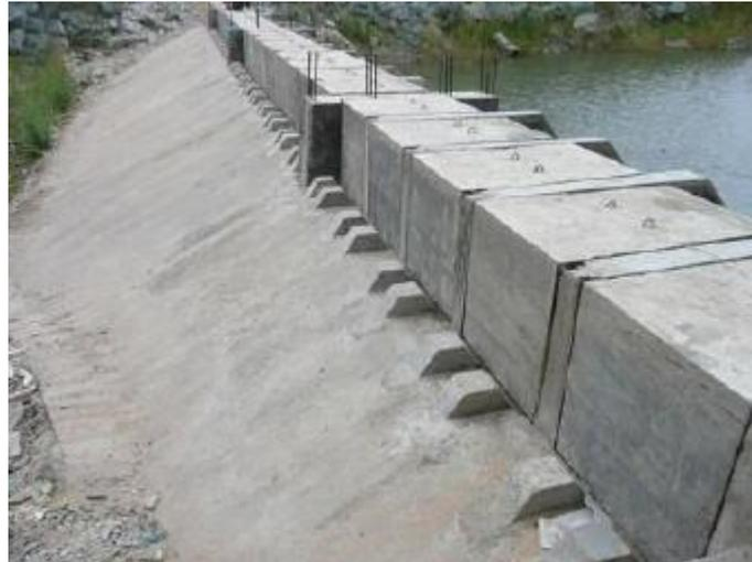
Figure IV.13 : Déversoir équipé par des blocs fusibles
