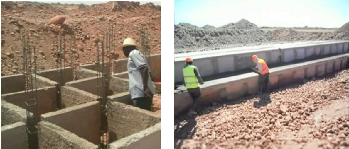
Figure IV.11: Construction des seuils par béton (Haous Marrakech royaume de Maroc 2013)
