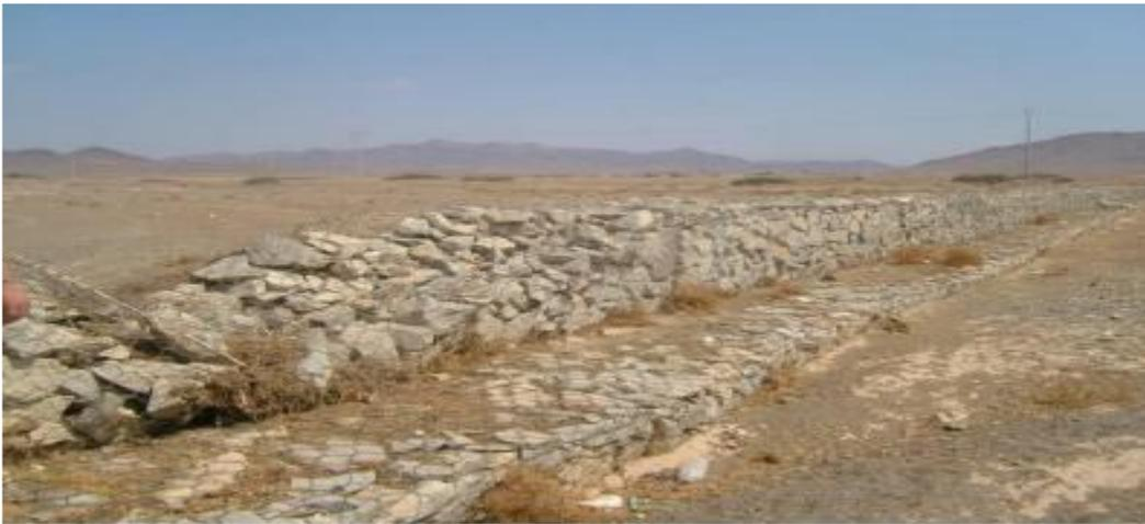
**Figure I.8 : Seuil en gabion [4]**
