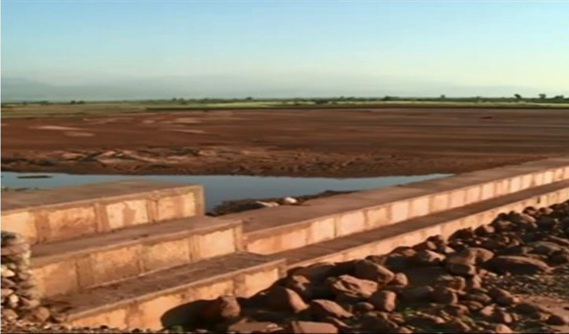
Figure IV.15 : Protection de la berge par seuil
