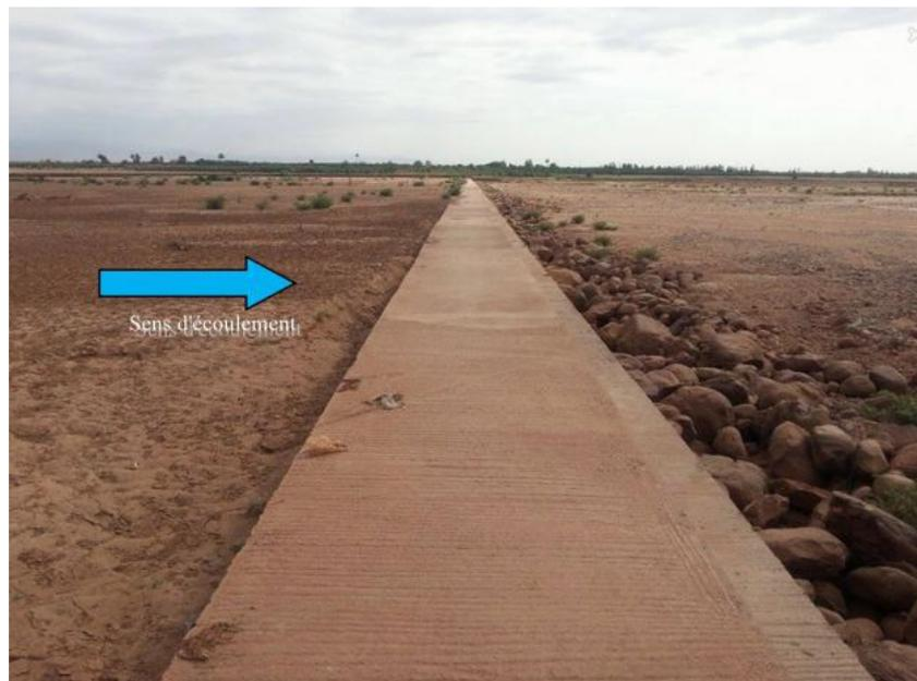
Figure I.11 : Le colmatage du bassin d'infiltration [4]
