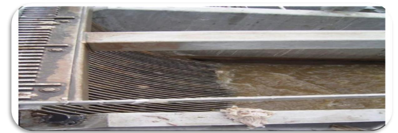
Figure 1 : Lamelles de dégrillage (ANONYME)
