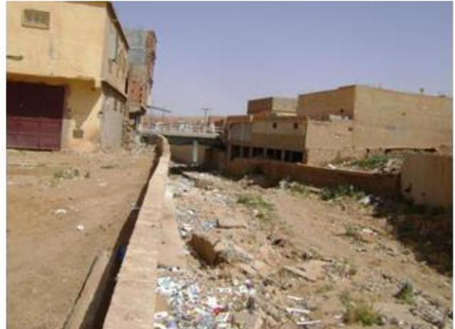
*Figure 2.11: Pont Grabba, rétrécissement de section*
