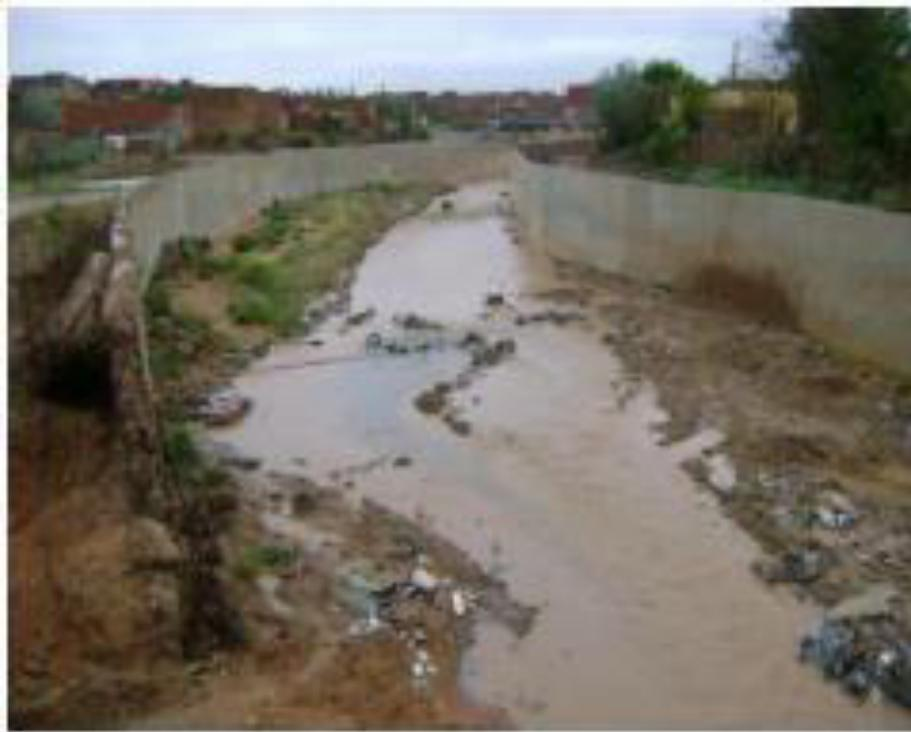
*Figure 2.13 : Oued Deffa avec les voiles de protection en partie détruits*
