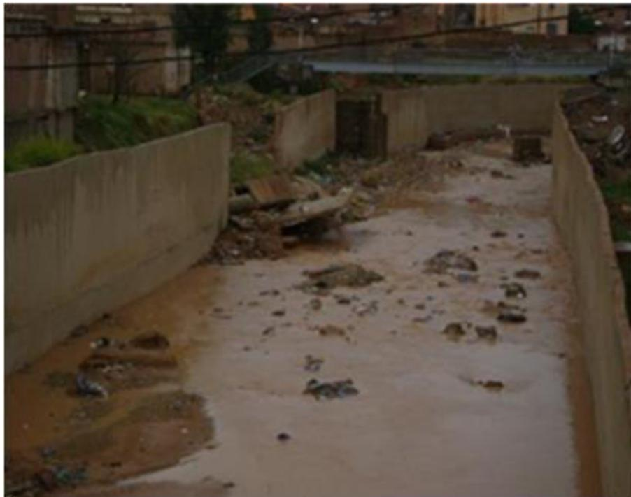
*Figure 2.14 : Oued Deffa avec les voiles de protection en partie détruits*
