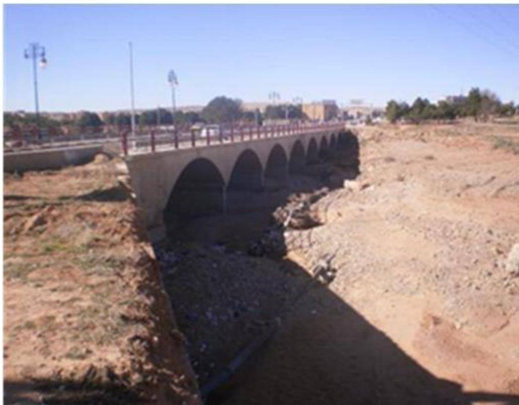
**Figure 2.9 :** *Pont menant vers Tiaret entrée de la ville avec une conduite d'AEP*
