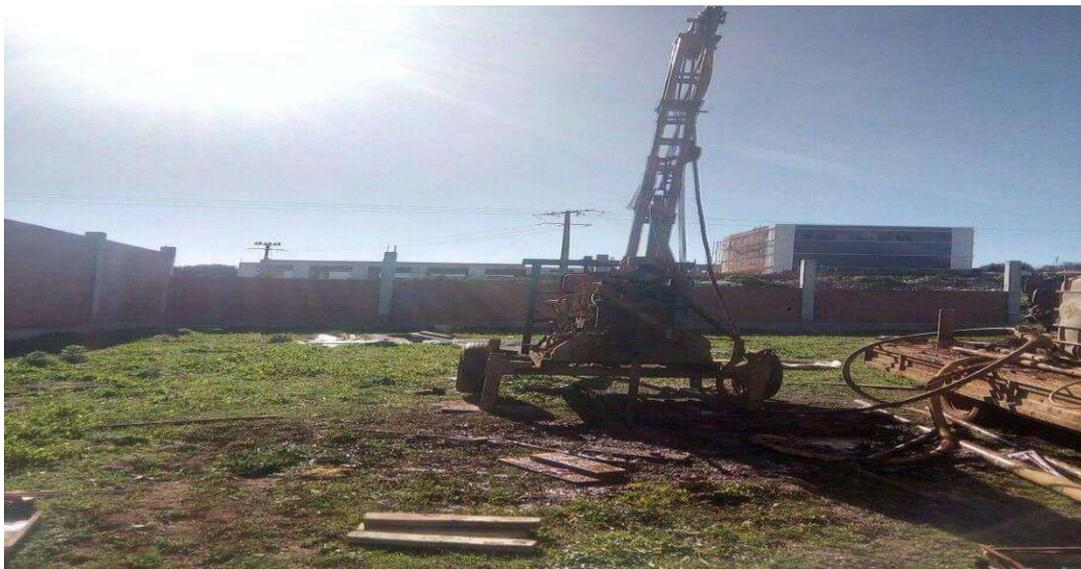
Le site destiné à recevoir l'implantation de projet dit Construction d'une unité de fabrication de cosmétiques en R+2+ sous-sol à Khemisti Tipaza, présente une topographie régulière sur un terrain plat, La reconnaissance in situ a révélé un terrain tout à fait homogène sur l'ensemble de l'assiette d'implantation. Cependant, il est constitué par une formation de base, il s'agit d'une calcaires gréseux sains à fracturés (voir profil A-A').
