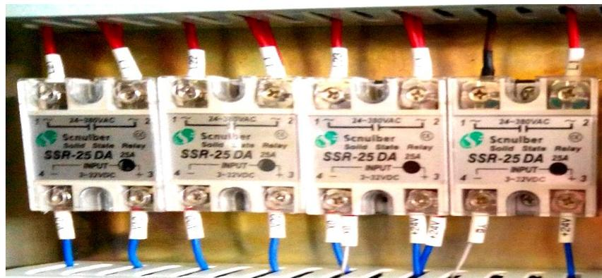
Figure I.7 schéma de Solide State Relay.
