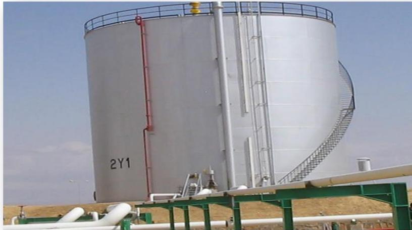
Figure 1.12 : Réservoir de décantation 2Y1.
