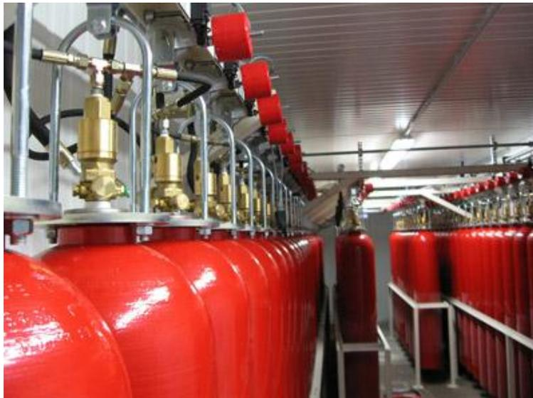
Figure I.12 : Rack de Bouteille CO<sub>2</sub>.
