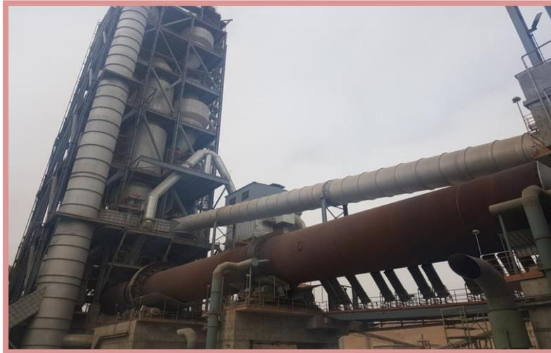
**Figure I.5:** Four rotatif de ciment.
