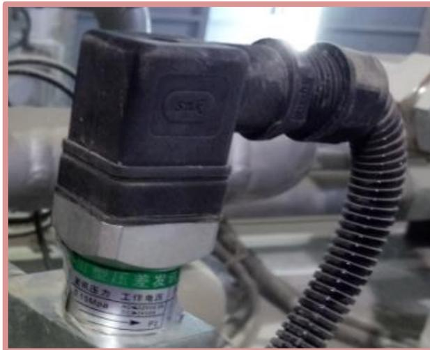
**Figure 1.16:** Capteur de pression différentielle.
